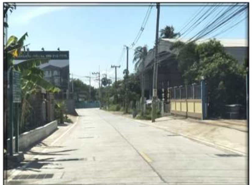
หลังทำถนน ค.ส.ล.พร้อมวางท่อระบายน้ำ
