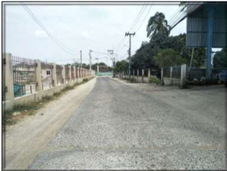
ก่อนทำถนน ค.ส.ล.พร้อมวางท่อระบายน้ำ
