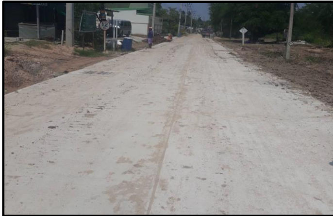
โครงการก่อสร้างถนน ค.ส.ล. พร้อมวางท่อระบายน้ำ บริเวณถนนสุขไพบูลย์ หมู่ที่ ๕
