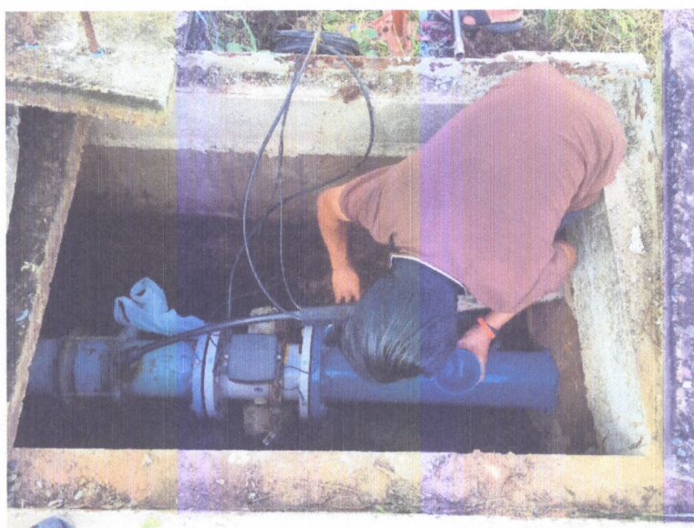
ภาพ การบำรุงรักษาทำความสะอาดบ่อมาตรวัดน้ำ และทาสีกันสนิมท่อน้ำประปา
