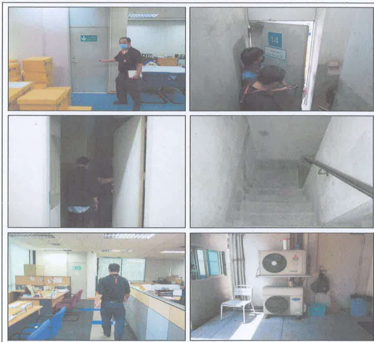
รูปแสดง สภาพระบบบันไดหนีไฟและทางหนีไฟ ขณะตรวจสอบ
