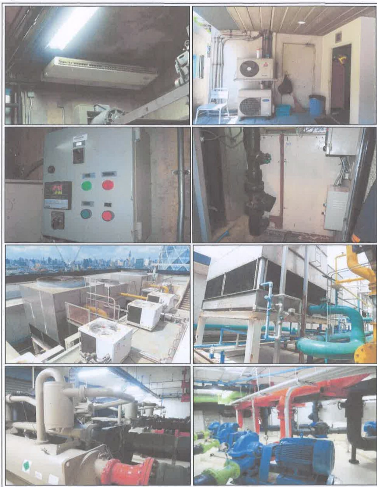
รูปแสดง สภาพระบบปรับอากาศขณะตรวจสอบ
