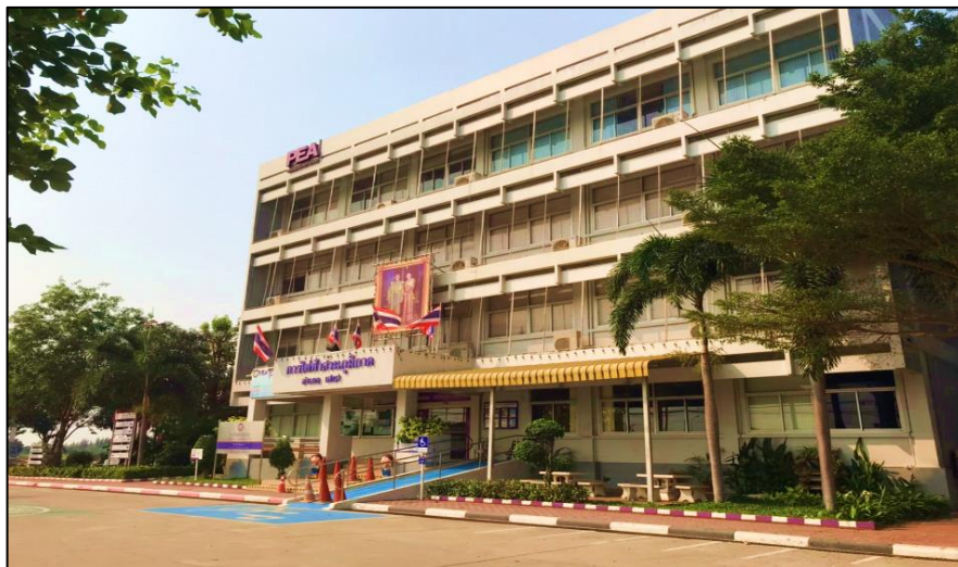
ภาพที่ ๑ อาคารสำนักงานการไฟฟ้าส่วนภูมิภาคอำเภอเสนา
