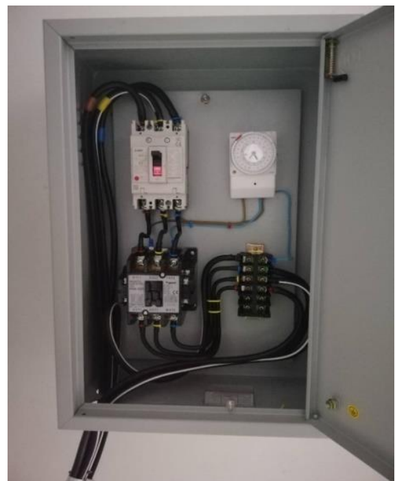
ภาพที่ ๒ การติดตั้งอุปกรณ์ควบคุมเวลาการทำงานเครื่องปรับอากาศ
