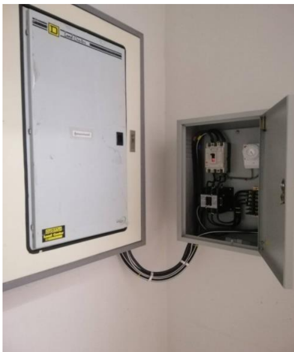
ภาพที่ ๒ การติดตั้งอุปกรณ์ควบคุมเวลาการทำงานเครื่องปรับอากาศ
