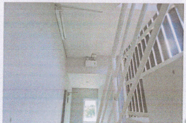
เส้นทางหนีไฟ-ไฟแสงสว่างสำรองฉุกเฉิน(Emergency Light)
