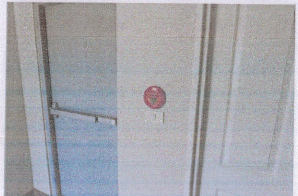
ไฟแสงสว่างสำรองฉุกเฉิน(Emergency Light) สัญญาณแจ้งเหตุด้วยมือ ประตุนิไฟ
