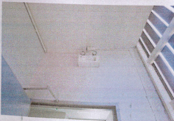
เส้นทางหนีไฟ-ไฟแสงสว่างสำรองฉุกเฉิน(Emergency Light)
