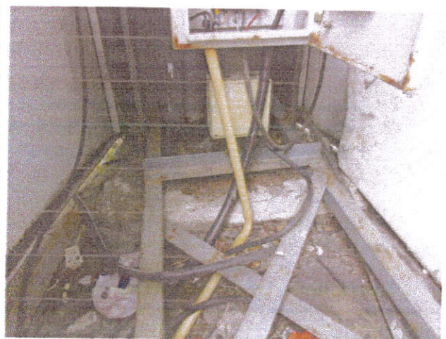
การต่อสายดินของระบบสายล่อฟ้า
