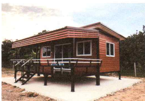
บ้านประกอบเสร็จ
