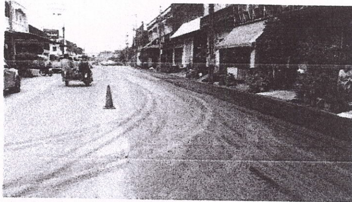
ภาพถ่ายผลงานโครงการก่อสร้างปรับปรุงผิวจราจรแอสฟัลต์ติกคอนกรีต รหัสทางหลวงท้องถิ่น ตง.ถ12-012 สายถนนพิบูลทอง
