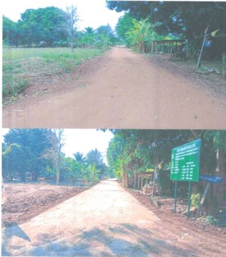
ก่อสร้างถนนคอนกรีตเสริมเหล็กบ้านบุ หมู่ที่ ๓ (สายมิตรภาพซอย ๖)
