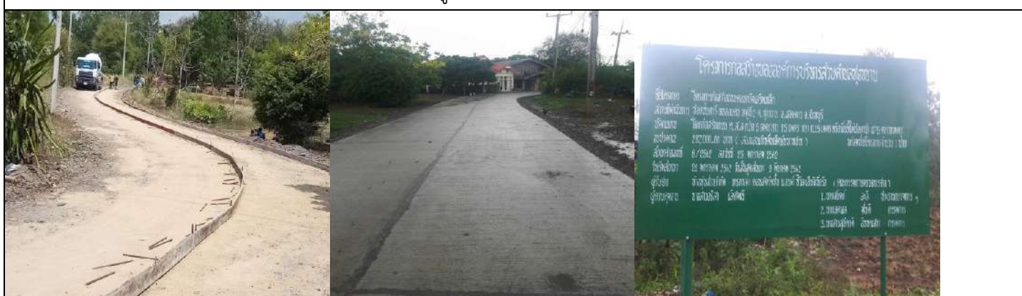
๗. โครงการก่อสร้างถนน คสล. ช.ท่าเอี่ยม หมู่ที่ ๑๒ - หมู่ที่ ๕ (งบประมาณ ๑๙๙,๘๐๐.-)
