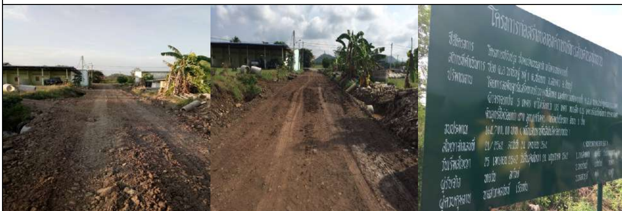
๒๗. โครงการปรับปรุง/ซ่อมแซมถนนลูกรังพร้อมวางท่อ ช.มะเดื่อ หมู่ที่ ๑๔ (งบประมาณ ๗๗,๗๐๐.-)
