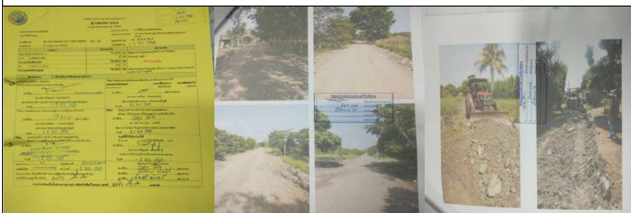
๒๒. โครงการปรับปรุง/ซ่อมแซมถนนลูกรัง ซ.หน้าตู้-ปากคลอง หมู่ที่ ๑๐ (งบประมาณ ๘๐,๐๐๐.-)
