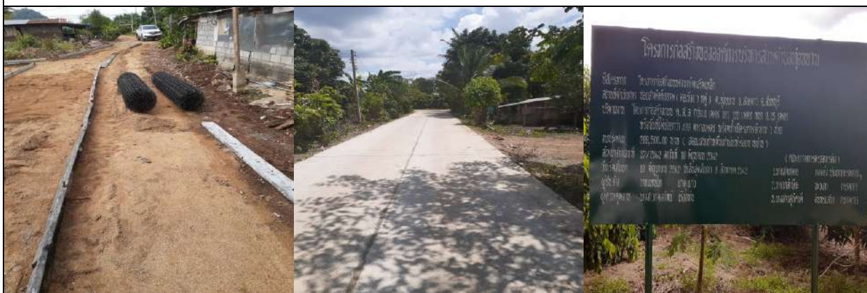
๓๑. โครงการขยายเขตประปาหมู่บ้าน หมู่ที่ ๔ (งบประมาณเบิกจ่าย ๑๑๓,๕๐๐.-)
