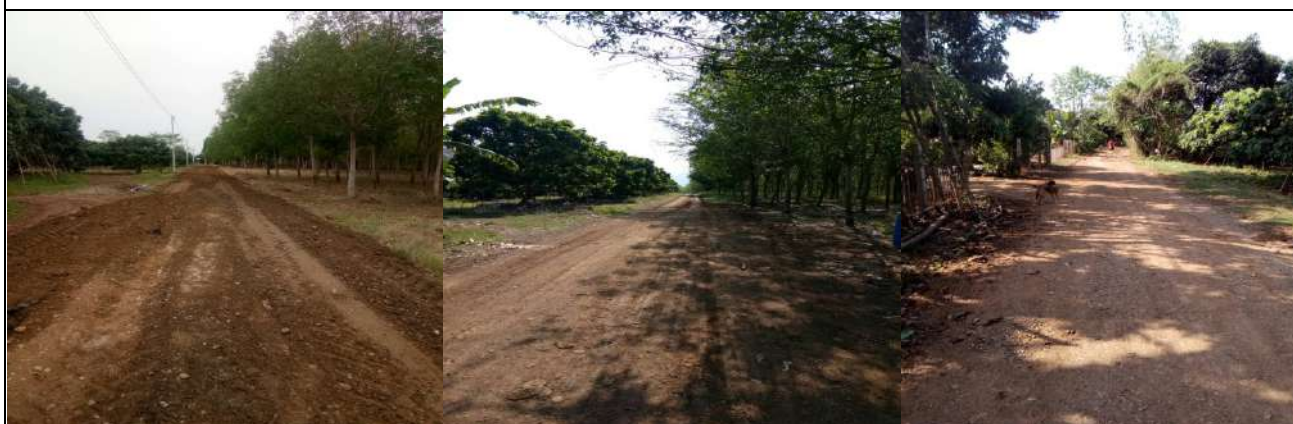
๑๙. โครงการซ่อมแซมถนนลูกรัง ซ.เตาถ่าน ๒ หมู่ที่ ๕ (งบประมาณเบิกจ่าย ๑๙๙,๕๐๐.-)
