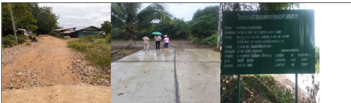
๕. โครงการก่อสร้างถนน คสล.ช. ข้างป้อม หมู่ที่ ๙ (งบประมาณ ๒๙๖,๕๐๐.-)
