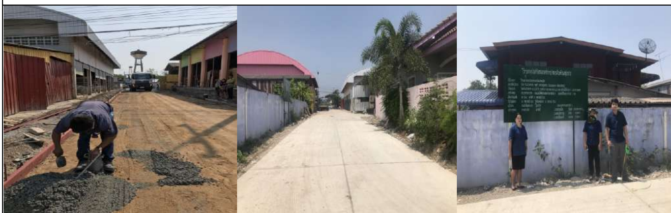
๑๒. โครงการก่อสร้างถนน คสล. ช.สำราญ(ต่อเนื่อง) หมู่ที่ ๑๔ (งบประมาณ ๒๙๙,๕๐๐.-)
