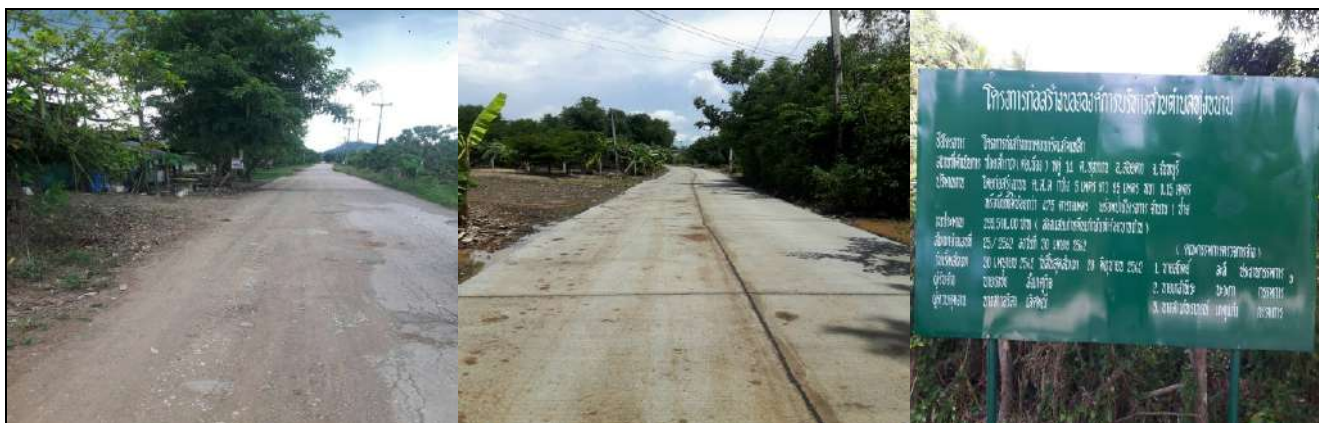
๑๓. โครงการก่อสร้างถนน คสล.ช.หลังอบต.ทุ่งขนาน ช.๑ หมู่ที่ ๑ (งบประมาณ ๒๙๙,๕๐๐.-)
