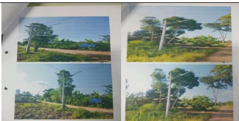
๑๗. โครงการปรับปรุง/ซ่อมแซมถนนลูกรัง ซ.๔ หมู่ที่ ๑๕ (งบประมาณเบิกจ่าย ๗๙,๘๐๐.-)
