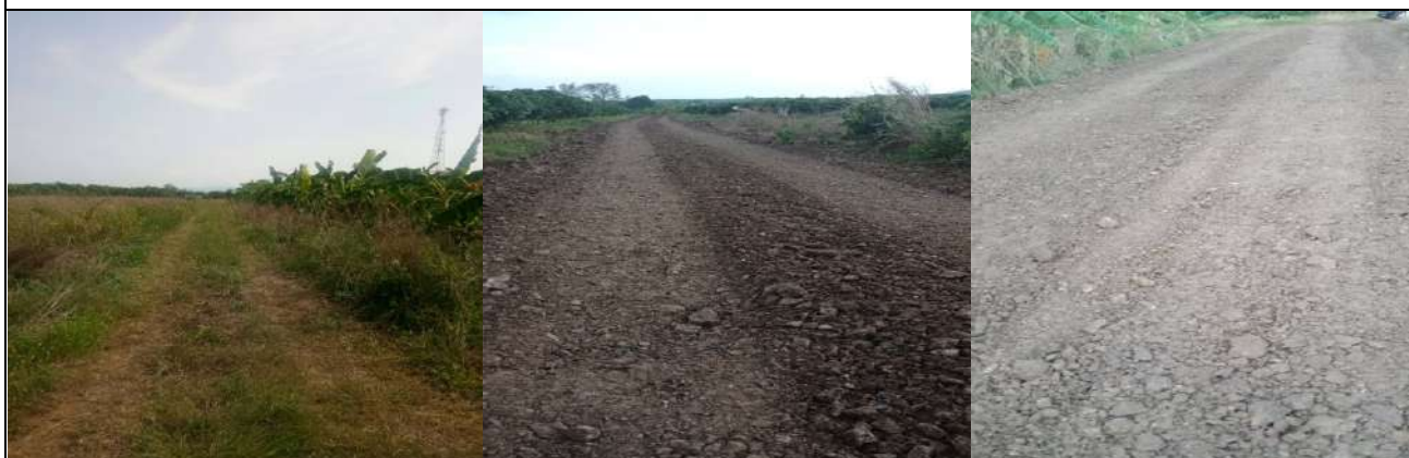
๒๐. โครงการซ่อมแซมถนนลูกรัง ซ.ปากกล้วย หมู่ที่ ๑๐ (งบประมาณ ๑๐๐,๐๐๐.-)
