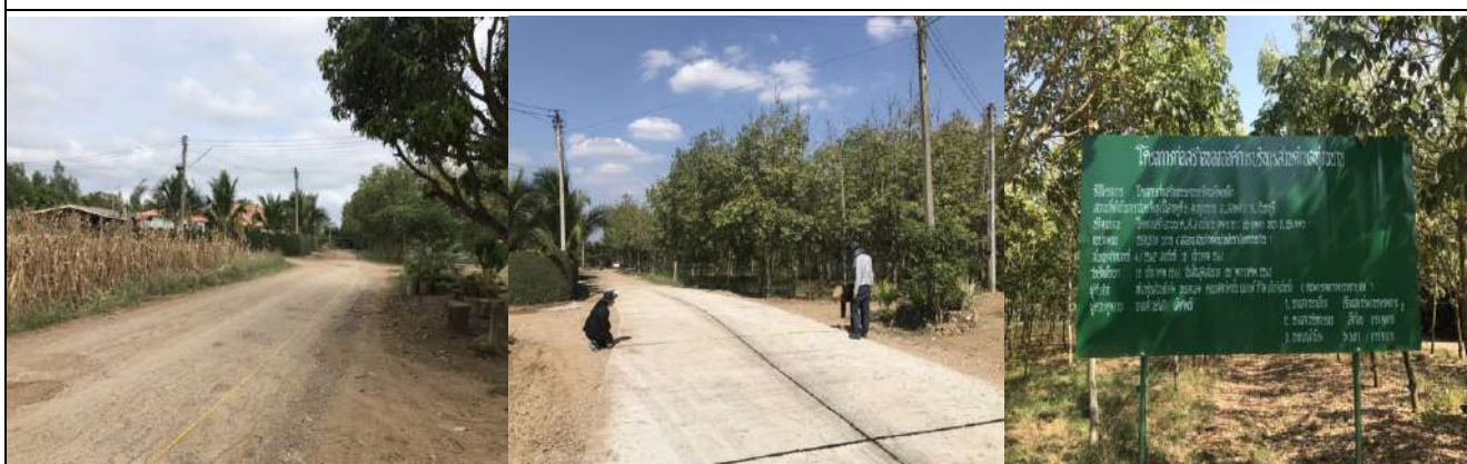
๑๑. โครงการก่อสร้างถนน คสล.ช.ศาลาประชาคม หมู่ที่ ๑ (งบประมาณ ๒๔๙,๕๐๐.-)
