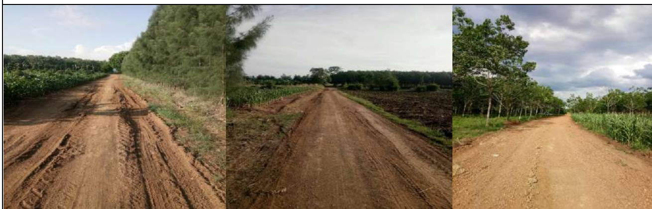
๑๘. โครงการซ่อมแซมถนนลูกรัง ซ.ต่ายม หมู่ที่ ๑๒-หมู่ที่ ๘ (งบประมาณเบิกจ่าย ๗๙,๘๐๐.-)
