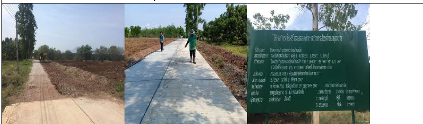
๖. โครงการก่อสร้างถนน คสล.ช.ซับตารี-หนองแคน หมู่ที่ ๒ (งบประมาณ ๒๙๗,๐๐๐.-)
