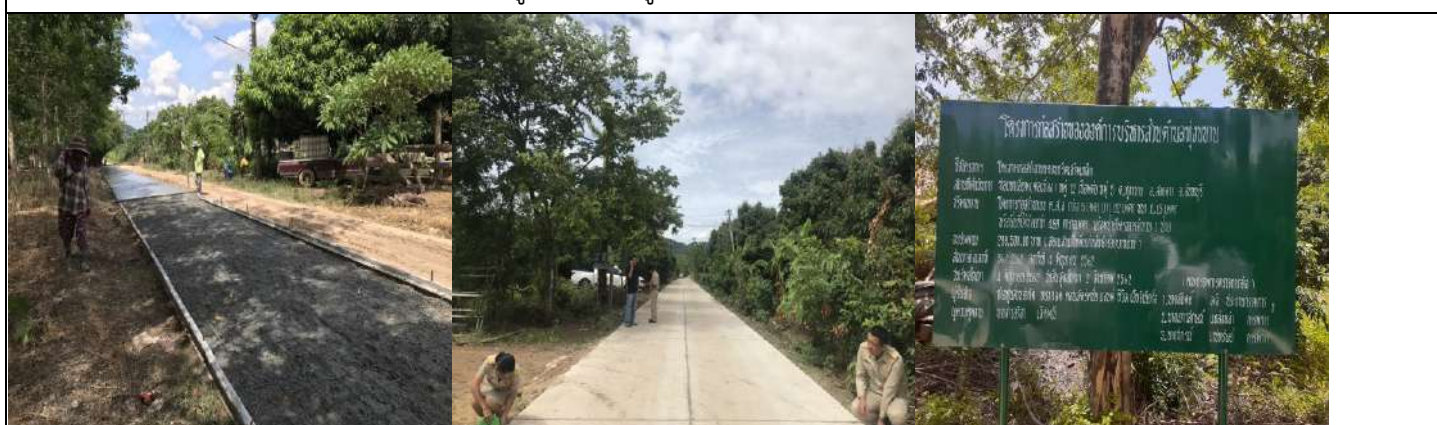
๘. โครงการก่อสร้างถนน คสล.ช.นิคมเศรษฐกิจ (ต่อเนื่อง) หมู่ที่ ๑๓ (งบประมาณ ๒๙๘,๕๐๐.-)
