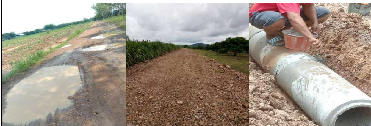
๒๖. โครงการปรับปรุง/ซ่อมแซมถนนลูกรังพร้อมวางท่อ ช.ผอ.วารินชัย หมู่ที่ ๑ (งบประมาณเบิกจ่าย ๑๖๔,๗๐๐.-)
