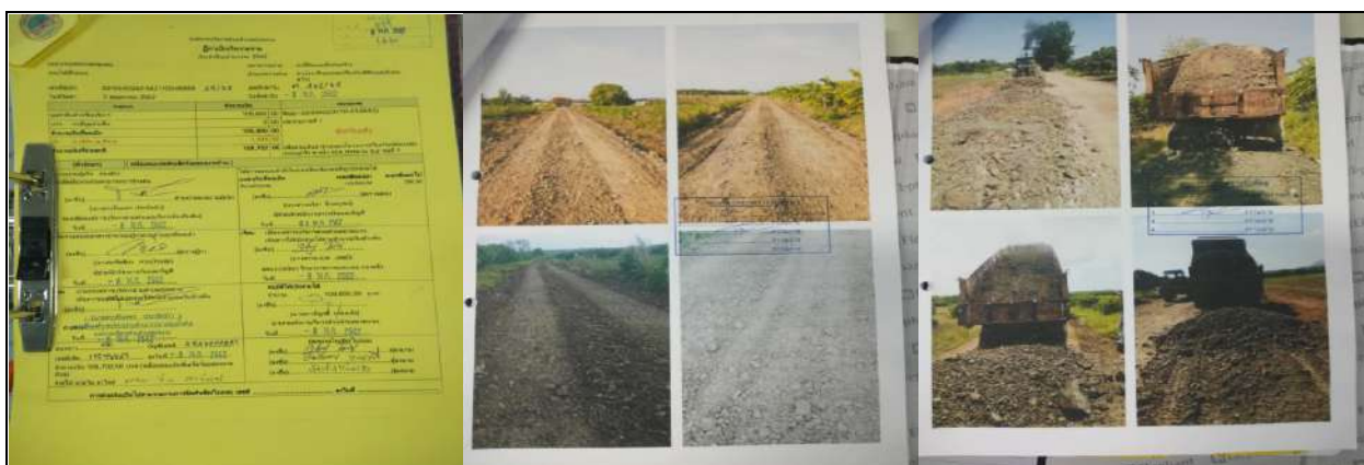
๒๕. โครงการปรับปรุง/ซ่อมแซมถนนลูกรังพร้อมวางท่อ ช.ทุ่งนา-หนองแคน หมู่ที่ ๕ (งบประมาณเบิกจ่าย ๑๖๙,๗๐๐.-)
