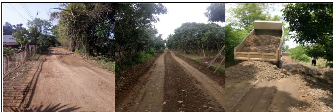
๒๑. โครงการซ่อมแซมถนนลูกรัง ซ.เลิศราตรี หมู่ที่ ๕ (งบประมาณเบิกจ่าย ๗๙,๘๐๐.-)
