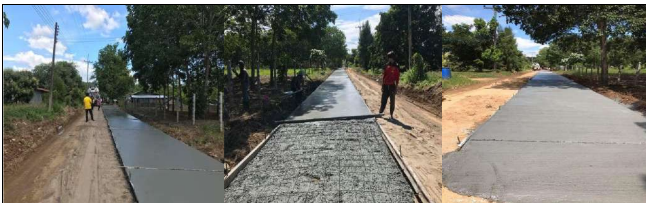
๙. โครงการก่อสร้างถนน คสล.ช.ลำดวน หมู่ที่ ๑ (งบประมาณ ๒๒๔,๐๐๐.-)
