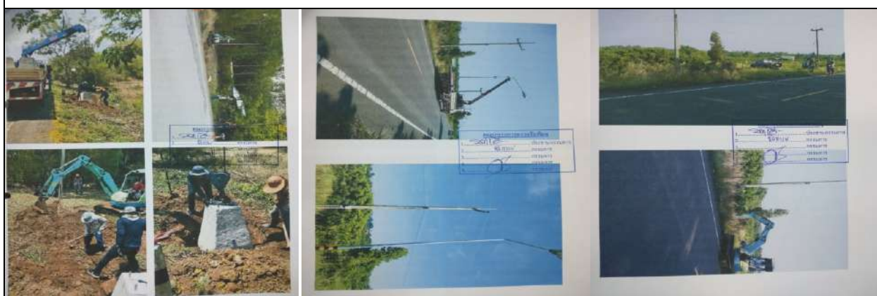
๑๖. โครงการติดตั้ง/ซ่อมแซมขยายเขตไฟฟ้าสาธารณะ (งบประมาณ ๑๐,๐๐๐.-)
