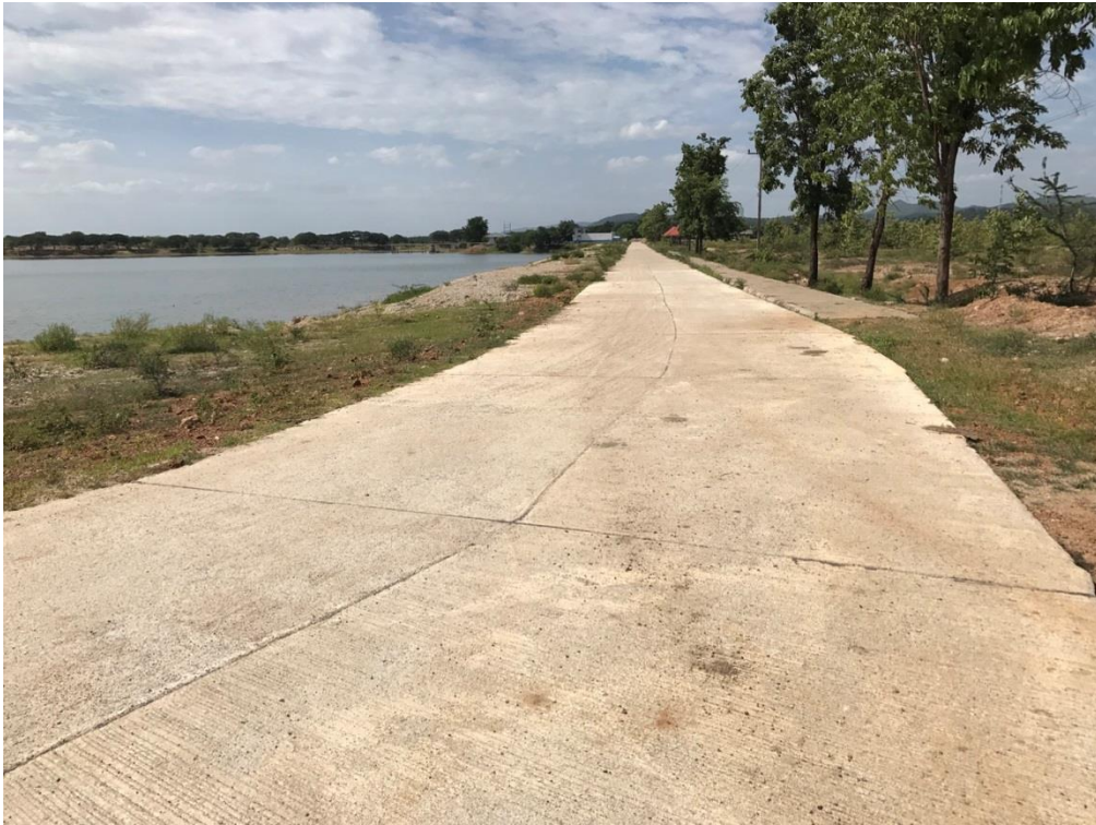
โครงการก่อสร้างถนนคอนกรีต (เส้นรอบบึงอีหมัน) หมู่ที่ 2 บ้านหนองย่างช้าง
