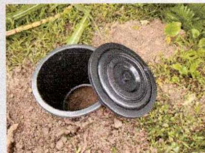
๒. ฝังดินที่มีความลึก ๒ ใน ๓ ของถังโดยให้ก้นถังเห็นจากก้นหลุม ๓๐ ซม.
