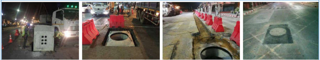
รูปภาพ การติดตั้งบ่อ Hand Hole
