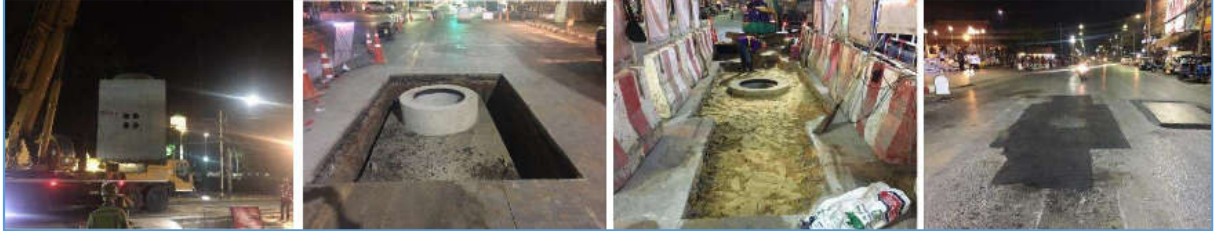
รูปภาพ การติดตั้งบ่อ Man Hole
