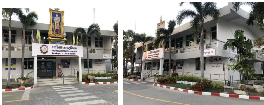
ภาพที่ ๑ อาคารสำนักงานการไฟฟ้าส่วนภูมิภาคอำเภอลำลูกกา
