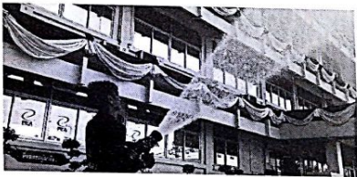
หน่วยดับเพลิงดำเนินการดับเพลิง
