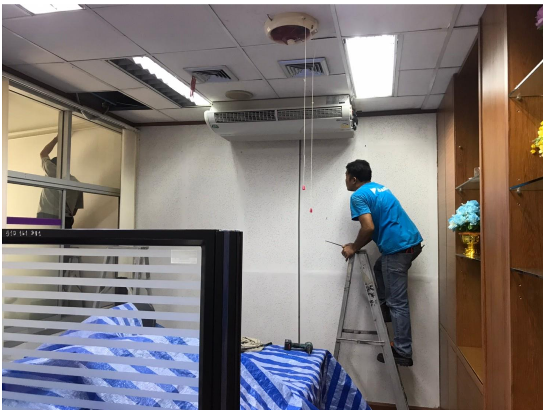
รูปการณเปลี่ยนเครื่องปรับอากาศ แบบ Inverter ภายในสำนักงาน กพท.1
