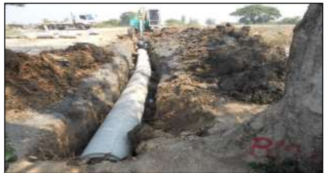
โครงการวางท่อระบายน้ำ คสล.จากคลองระบายใหญ่แม่น้ำน้อย ๒ ถึงคูส่งน้ำลือก ๔ หมู่ที่ ๘ (เงินสะสม)
