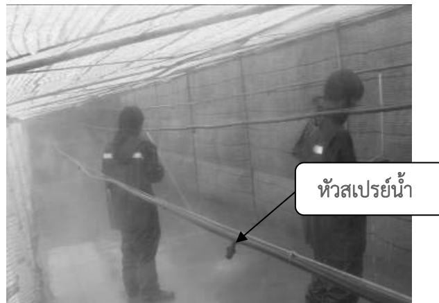
รูปที่ 7.3-19 แสดงลักษณะภายในของระบบกรงกลิ้งมันน้ำกระจายเต็มพื้นที่
