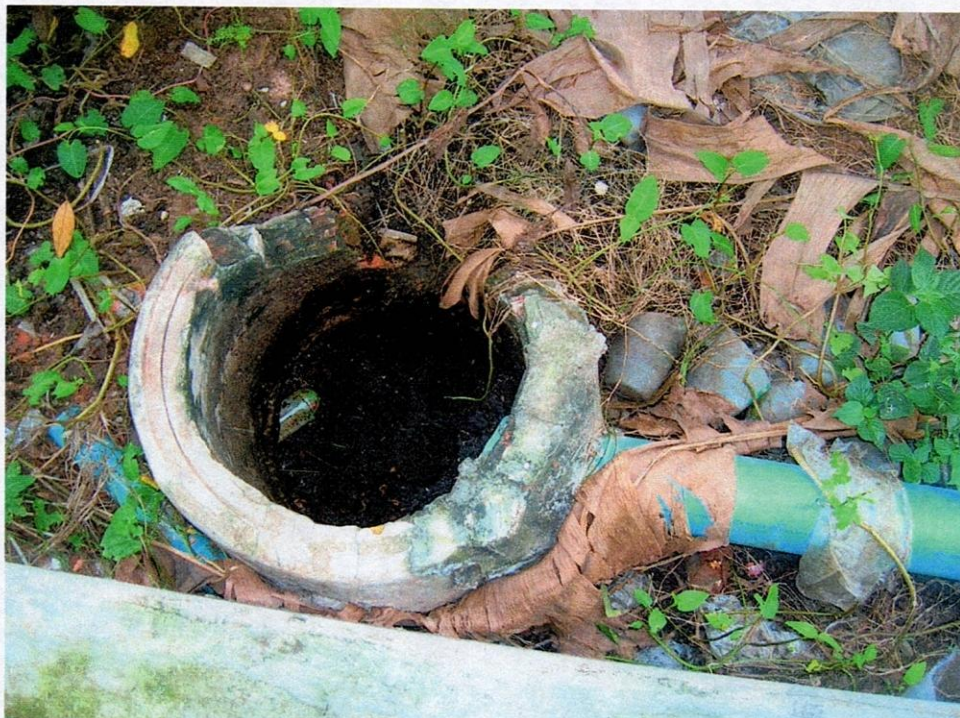
ภาพที่ 2.1-4 สภาพทั่วไปของบ่อดักไขมัน (เดิม) ของโรงฆ่าโค
