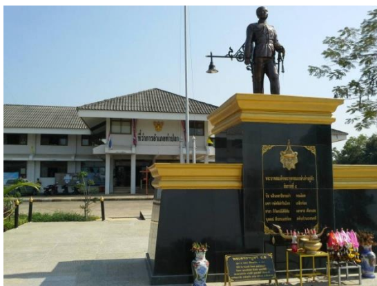
รูปภาพที่ ๒ ที่ทำการอำเภอท่าปลา (ปัจจุบัน)
