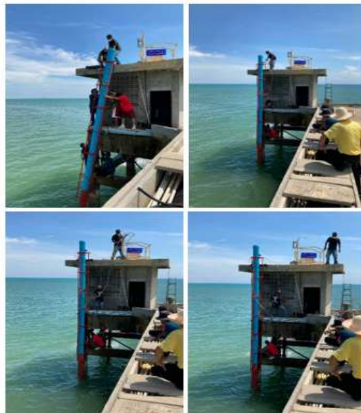
รูปที่ 6 การติดตั้งอุปกรณ์ไหลตหวัดรังสีได้น้ำทะเลจังหวัดสงขลา
