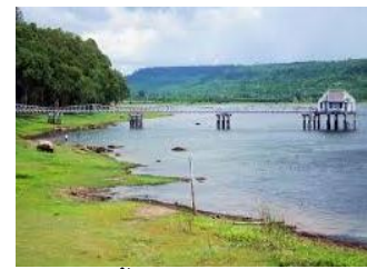
อ่างเก็บน้ำชลประทานห้วยหลวง
