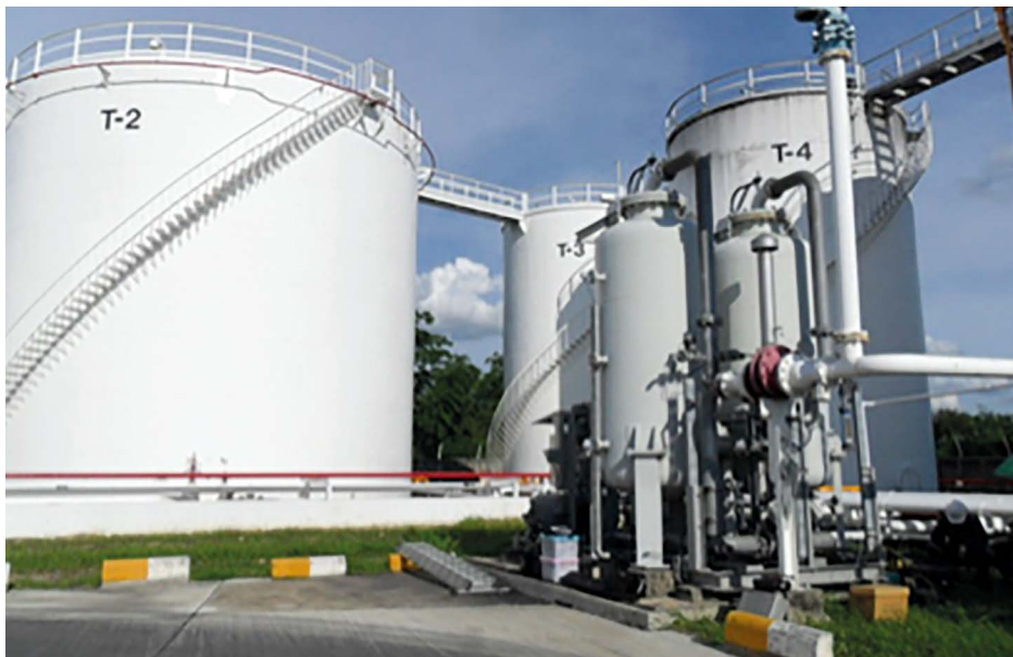
รูปที่ 3-3 ระบบควบคุมไอระเหยน้ำมันเบนซิน (Vapour Recovery Unit) แบบ Carbon Adsorption
