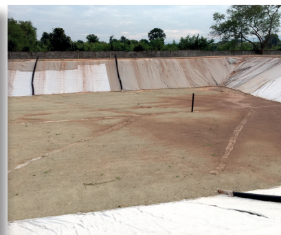
บ่อฝังกลบขยะมูลฝอยแบบกึ่งใช้อากาศของเทศบาลเมืองสีคิ้ว จังหวัดนครราชสีมา
