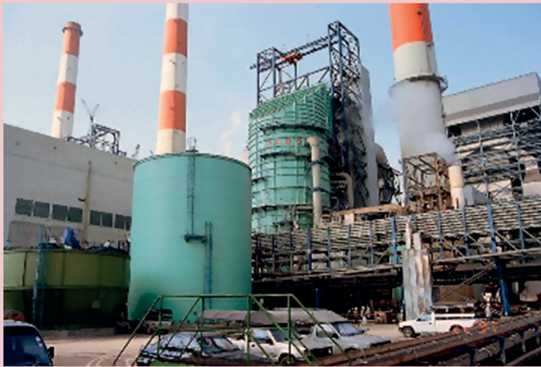
ภาพแสดงโรงไฟฟ้าแม่เมาะ และระบบกำจัด ก๊าซซัลเฟอร์ไดออกไซด์
