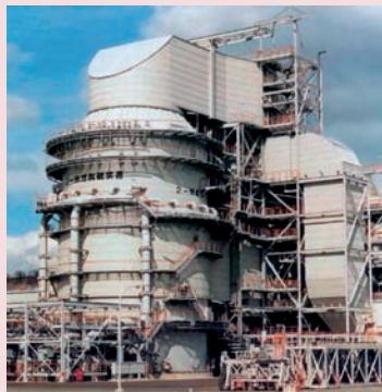
ภาพแสดงตัวอย่างระบบกำจัดก๊าซซัลเฟอร์ไดออกไซด์แบบเปียก และการติดตั้งในระบบผลิตไฟฟ้า (ที่มา www.babcock.com และ www.en.citizendium.org )
