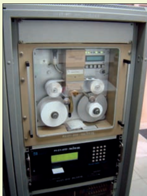
ภาพแสดงเครื่องมือตรวจวัดคุณภาพอากาศในบรรยากาศที่ติดตั้งภายในสถานี ในภาพประกอบด้วยเครื่องตรวจวัดฝุ่นละอองขนาดเล็กกว่า 10 ไมครอนชนิดรังสีเบต้า และเครื่องวัดปริมาณก๊าซในบรรยากาศ
