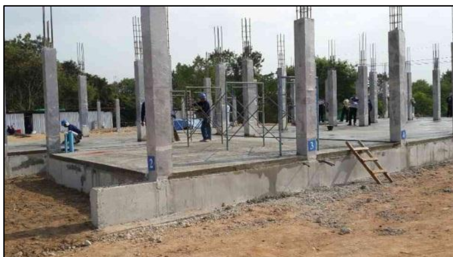
ภาพที่ 2.18 การก่อสร้างอาคารศูนย์ควบคุมมลพิษ จ. ระยอง ณ วันที่ 8 มกราคม 2558
