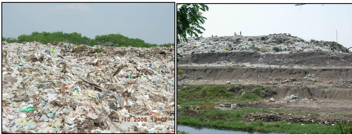
ภาพที่ 4.7 ระบบเทกอง (Open Dump) และระบบแบบเทกองที่มีการควบคุม (Controlled Dump)
