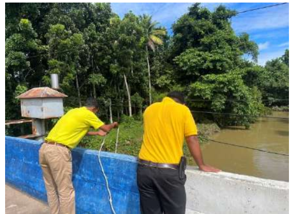
DM๑๐ สะพานบ้านบูเก็ตยามู
