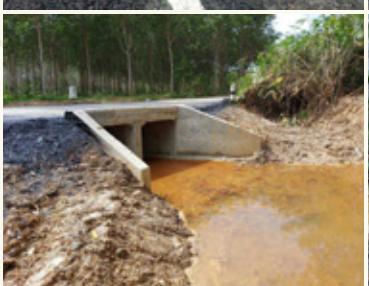
ก่อสร้างท่อเหลี่ยมคอนกรีตเสริมเหล็ก บนสายทางถนนหน้าโรงเรียนบ้านห้วยมะพร้าว - ผัง41 อ.ละงู จ.สตูล
