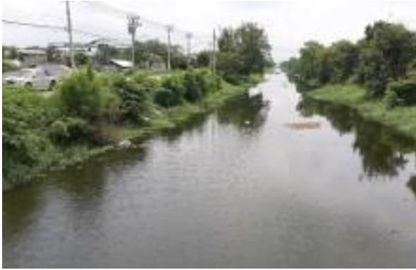
คลองเจ๊ก (KJ2) (สะพานข้ามถนน 340)
