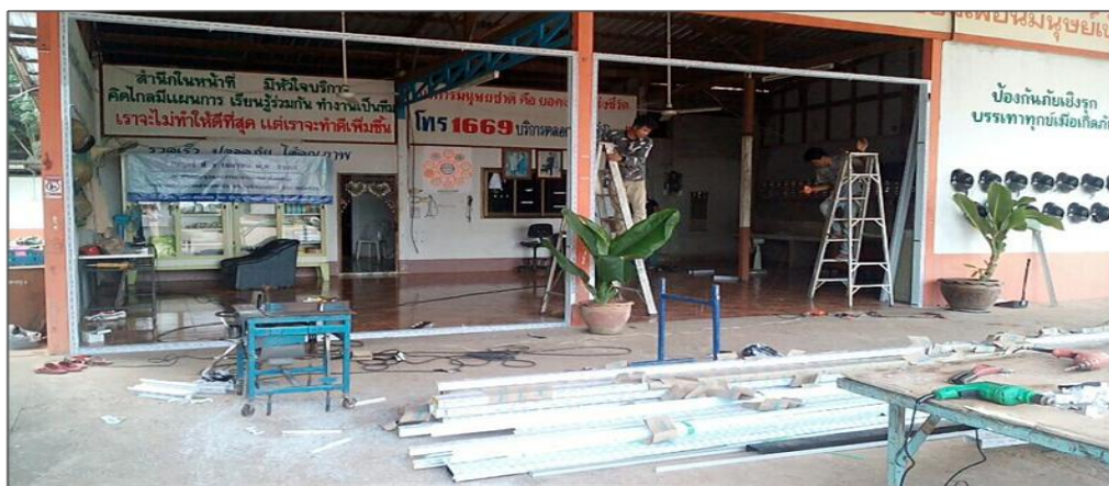
ขณะดำเนินการติดตั้งแผงกระจกอลูมิเนียมพร้อมบานประตูบานเลื่อน
