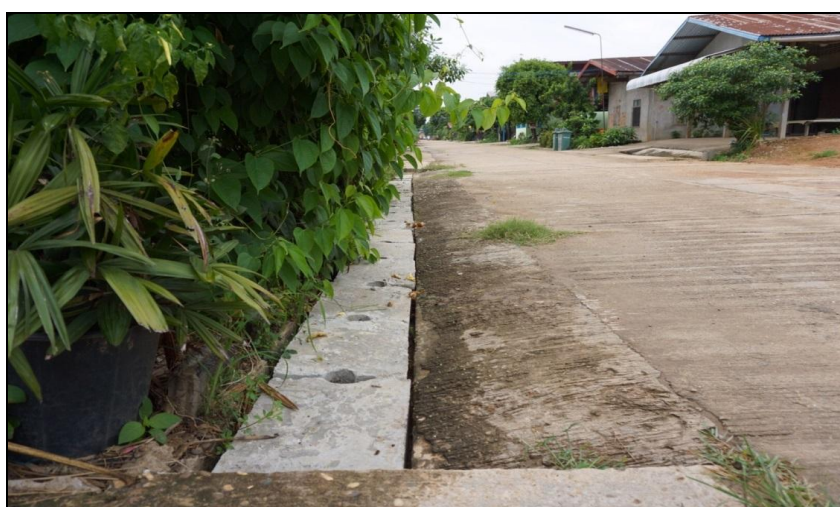
ดำเนินการติดตั้งฝารางระบายน้ำแล้วเสร็จ
