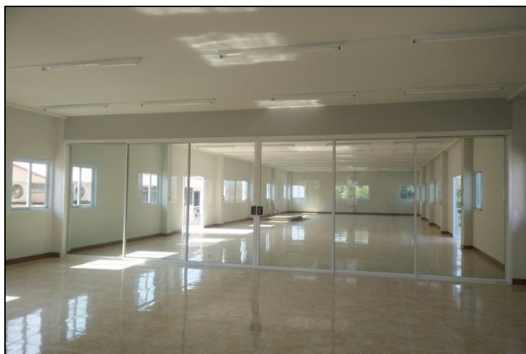
ดำเนินการก่อสร้างแล้วเสร็จ ชั้นบน
