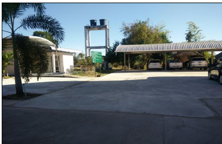
ดำเนินการก่อสร้างแล้วเสร็จ ด้านทิศเหนือ
