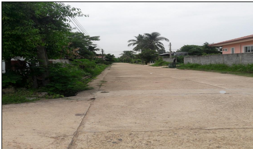
ก่อนดำเนินการติดตั้งฝารางระบายน้ำ
