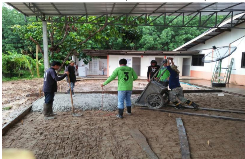
รูปขณะดำเนินการเทพื้นคอนกรีต
