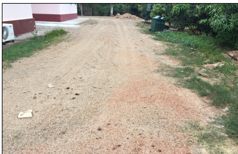
ก่อนดำเนินการก่อสร้าง ด้านทิศใต้
