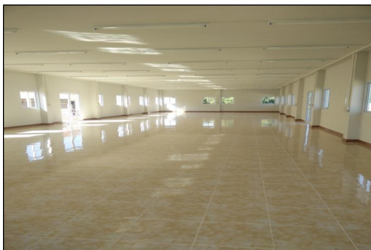
ก่อนดำเนินการชั้นบน
