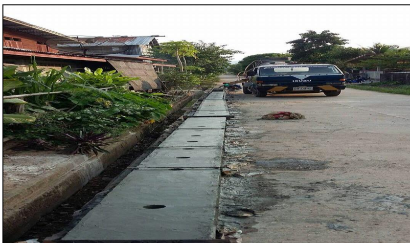
ขณะดำเนินการหล่อคอนกรีตฝารางระบายน้ำ ค.ส.ล. แบบที่ 1
