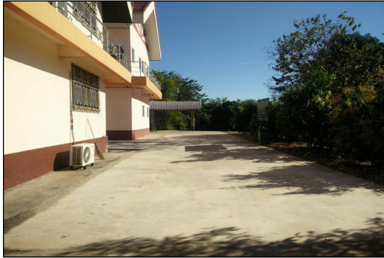
ดำเนินการก่อสร้างแล้วเสร็จ ด้านทิศใต้
