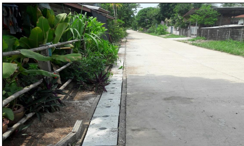
ดำเนินการติดตั้งฝารางระบายน้ำ ค.ส.ล. แบบที่ 1 เรียบร้อย
