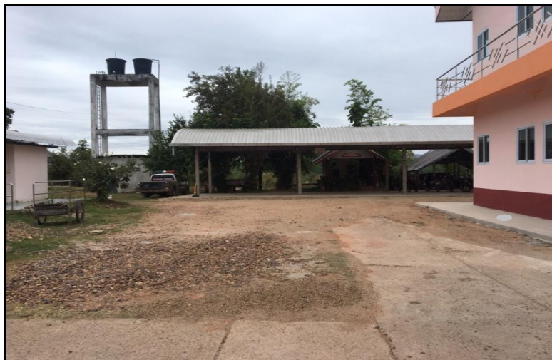
ก่อนดำเนินการก่อสร้างด้านทิศเหนือ
