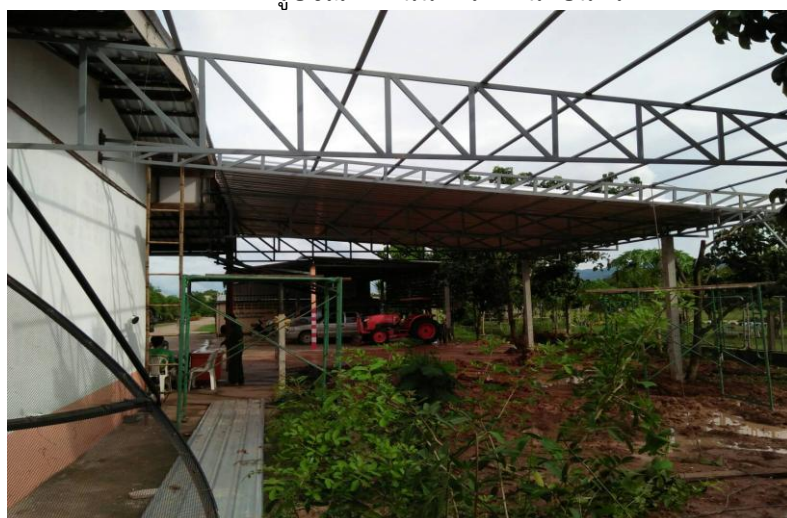
รูปดำเนินการติดตั้งโครงหลังคา
