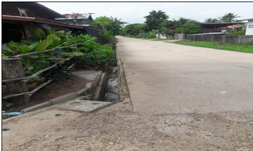
ก่อนดำเนินการติดตั้งฝารางระบายน้ำ
