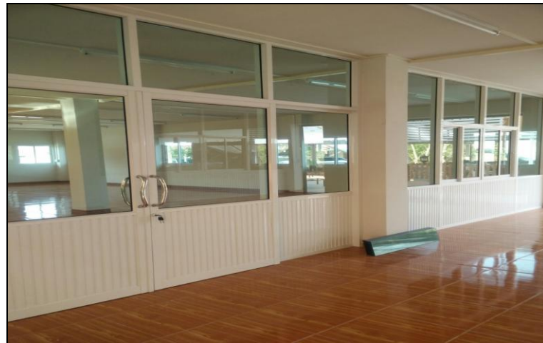
ดำเนินการก่อสร้างแล้วเสร็จ ด้านทิศเหนือผ1 กับ ผ2
