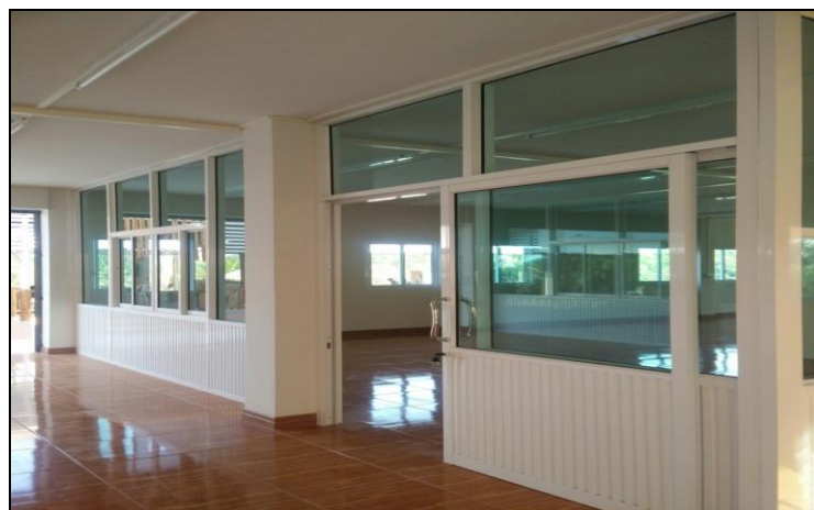
ดำเนินการก่อสร้างแล้วเสร็จ ด้านทิศใต้ ผ1 กับ ผ3
