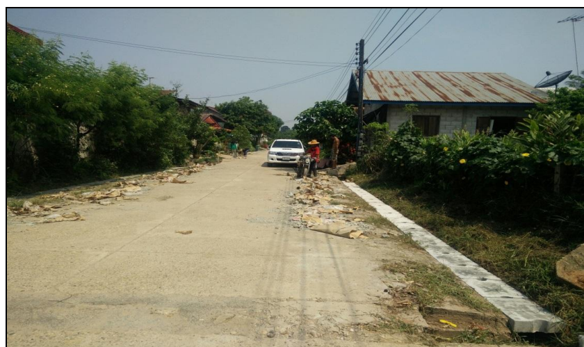
ขณะดำเนินการติดตั้งฝารางระบายน้ำ
