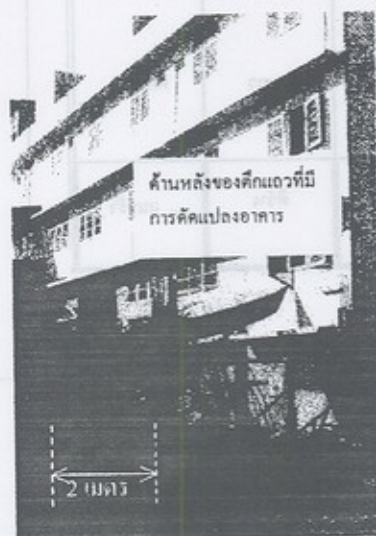
รูปที่ 2. ภาพถ่ายแสดงตัวอย่างลักษณะการดัดแปลงอาคารในที่ว่าง
