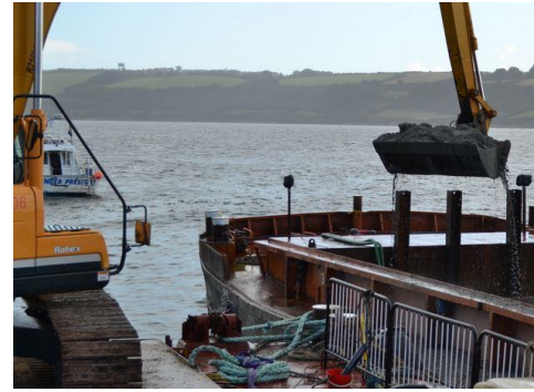
ขุดแบบเครื่องมือกล (Mechanical Dredging) หรือ รถแบบโซบนโป๊ะบรรทุก
