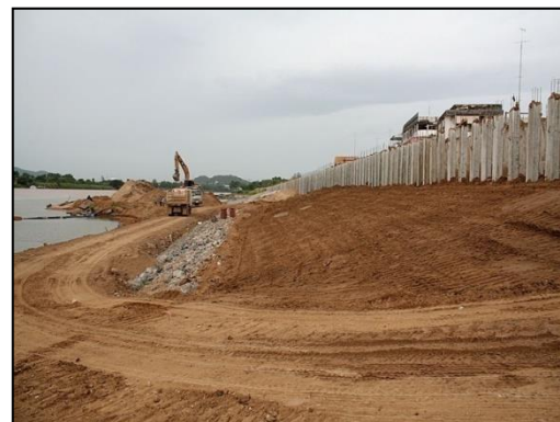
รูปที่ 5.1.2-3 ตัวอย่างบ่อพักตะกอนสำหรับการขุดลอกแบบ Cutter Suction
