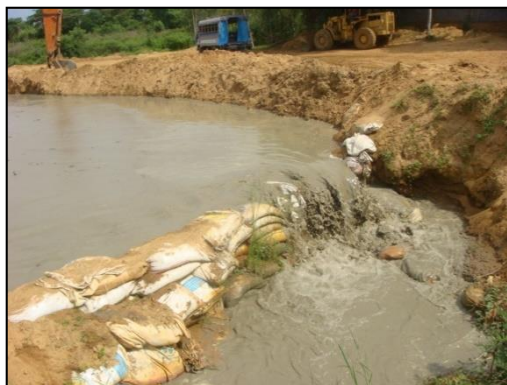
รูปที่ 5.1.2-3 ตัวอย่างบ่อพักตะกอนสำหรับการขุดลอกแบบ Cutter Suction
