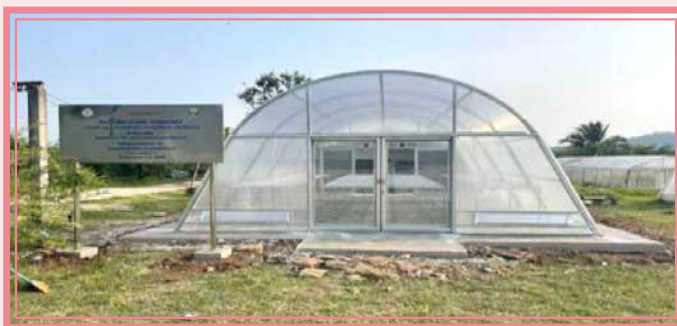
ภาพที่ ๒ ระบบอบแห้งพลังงานแสงอาทิตย์ แบบ พพ.๑ ขนาด ๖ x ๔.๒๐ เมตร ณ โครงการพัฒนาบ้านแม่ต๋ำ ตามพระราชดำริ
