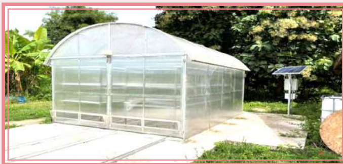
ภาพที่ ๔ ระบบอบแห้งพลังงานแสงอาทิตย์ ขนาด ๓ x ๔ เมตร ณ กลุ่มวิสาหกิจชุมชนเกษตรแปรรูปชุมชนคนลำปาง จำนวน ๑ ระบบ
