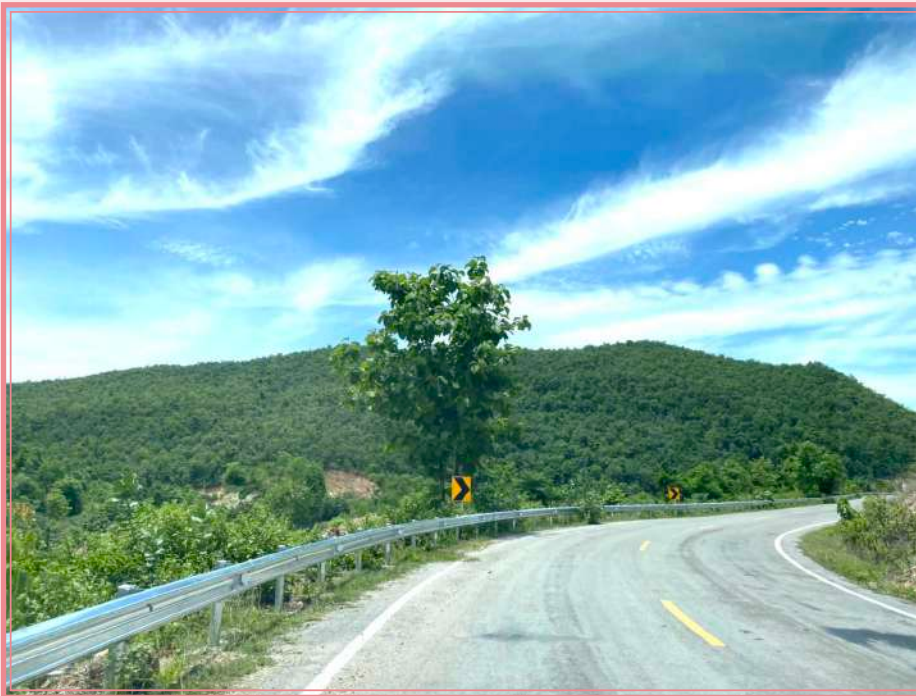
ดำเนินการติดตั้งราวกันอันตรายแล้วเสร็จ
