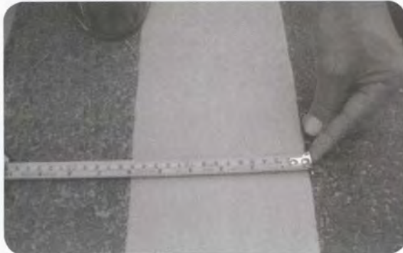
การตรวจสอบขนาดของเส้นจราจร
