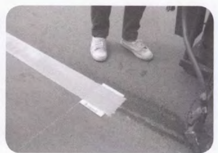
รูปที่ ๓๔ กดแผ่นเหล็กให้อยู่กับที่ขณะทาสี เมื่อสีแห้งยกแผ่นเหล็กมาตรวจสอบสี ทาสีผ่านแผ่นเหล็กที่วาง
