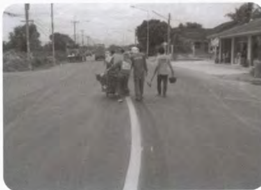
รูปที่ ๓๒ การทำ Primer ด้วยผลิตภัณฑ์ของผู้ผลิตสี ทำการทาสีด้วยเครื่อง ที่ควบคุมอุณหภูมิได้ รูปขณะดำเนินการตีเส้นจราจร
