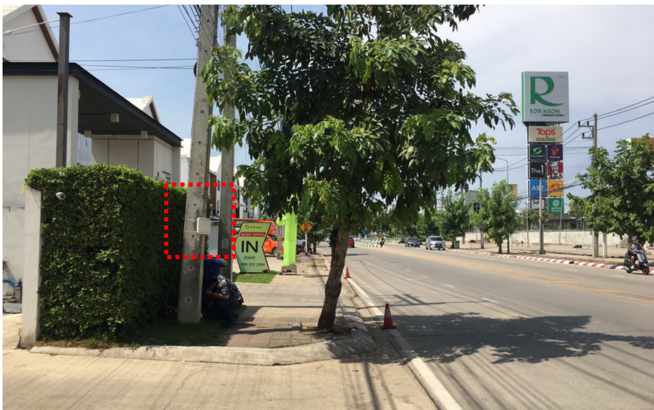
รูปที่ 5.58 การติดตั้งอุปกรณ์ RFID Antenna
