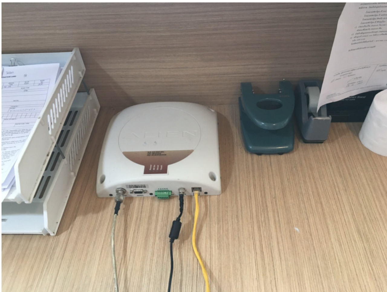
รูปที่ 5.57 การติดตั้งอุปกรณ์ RFID Reader
