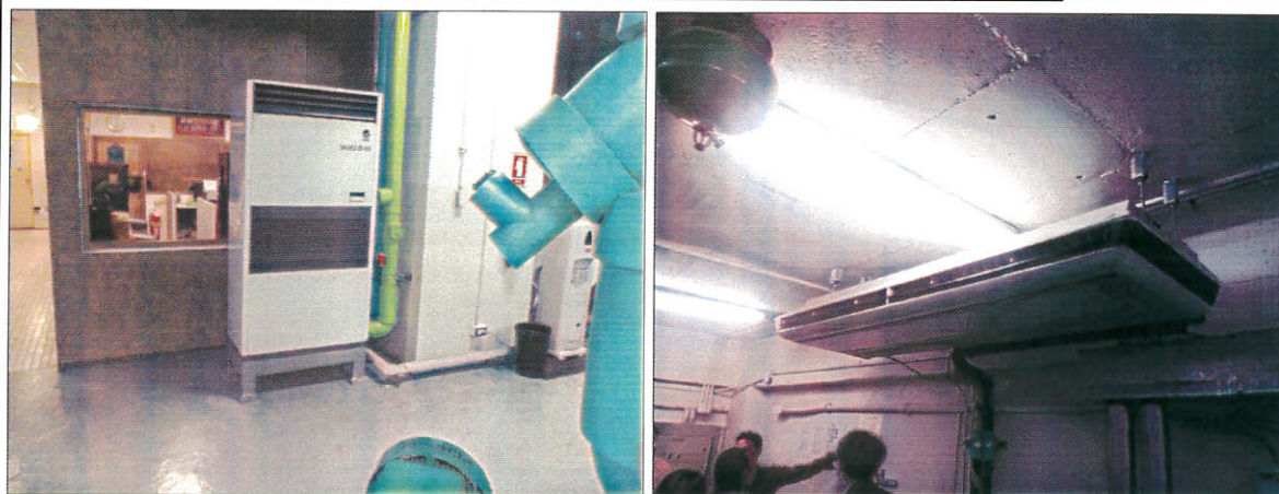
สภาพระบบปรับอากาศแบบแยกส่วน ขณะตรวจสอบ
