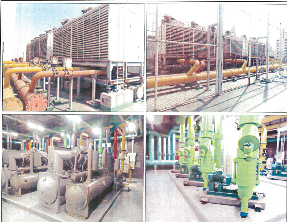
สภาพระบบปรับอากาศแบบรวมศูนย์ ขณะตรวจสอบ
