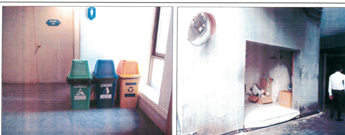
สภาพระบบจัดการมูลฝอย ขณะตรวจสอบ
