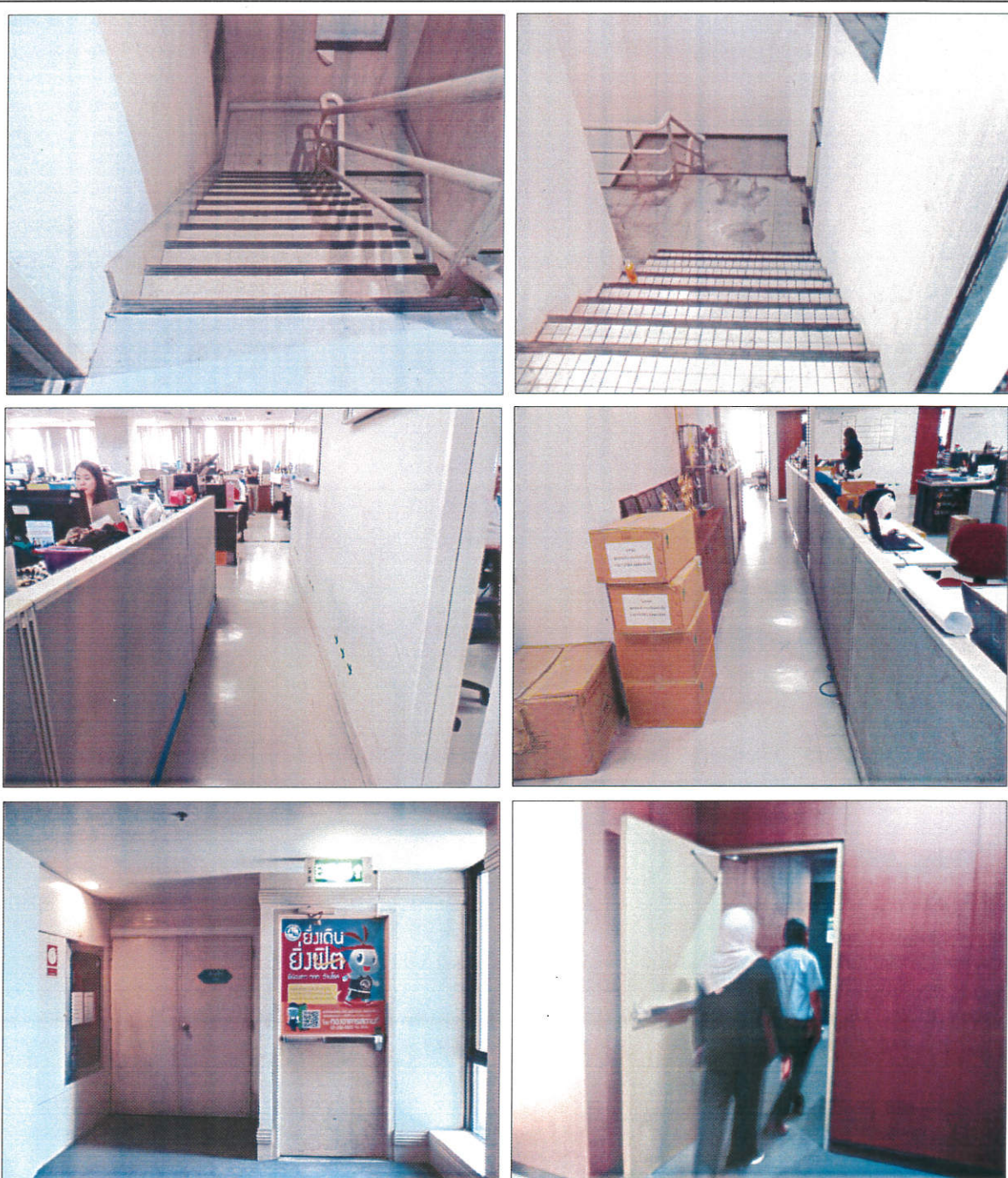
สภาพระบบบันไดหนีไฟและทางหนีไฟ ขณะตรวจสอบ
