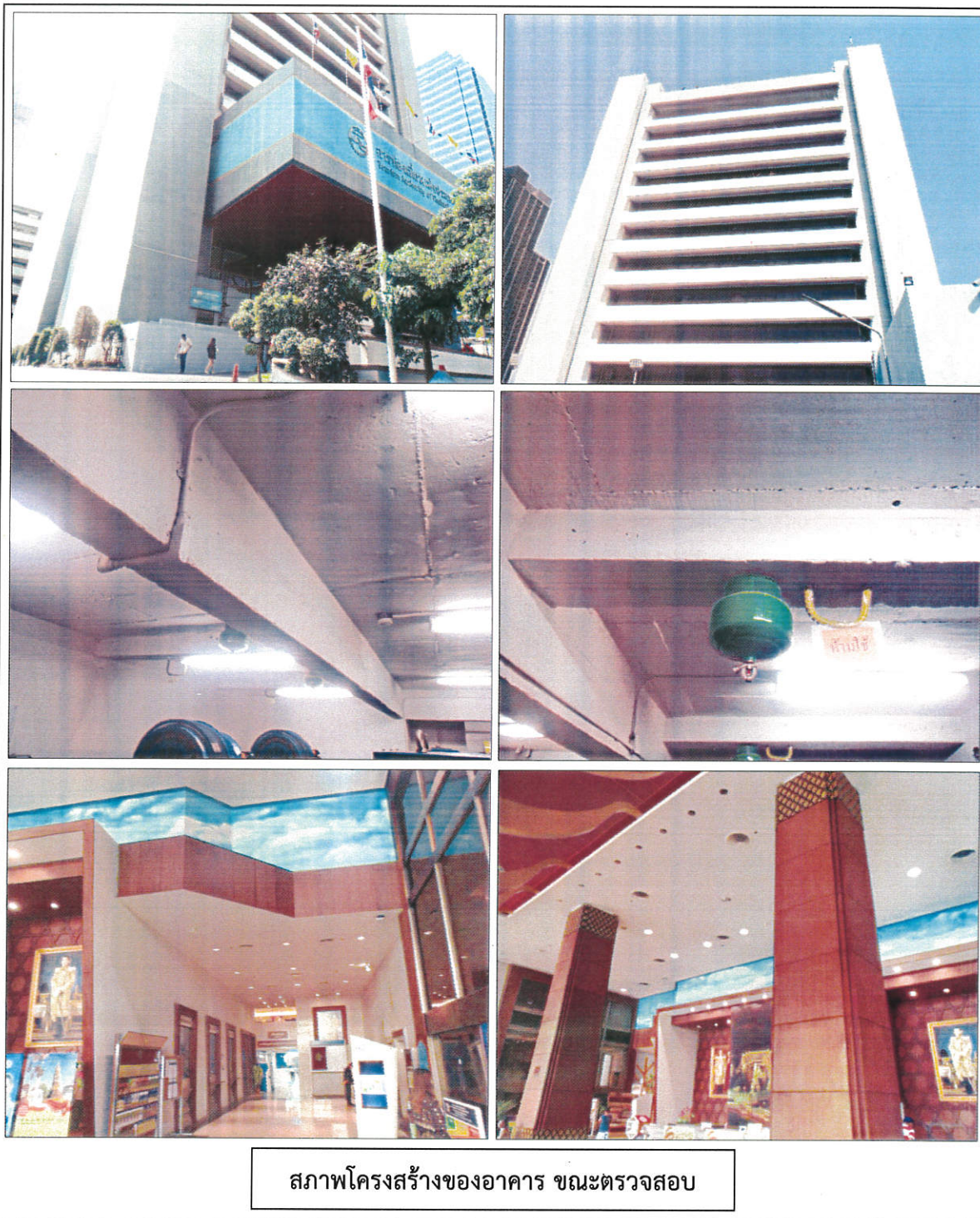
รูปแสดง สภาพโครงสร้างของอาคาร ขณะตรวจสอบ
