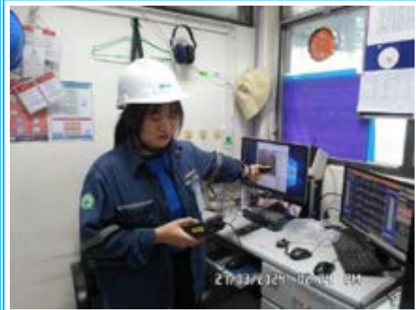
โรงสูบน้ำดิบ 1 Control Room โต๊ะคอมพิวเตอร์ No.1 (คุณวสุ ดินตะโมะระ)
