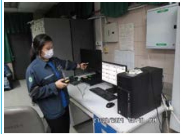
สถานีตกตะกอน Line 2 โต๊ะคอมพิวเตอร์ No.1 (คุณพีระศักดิ์ ศรีอรุณ)
