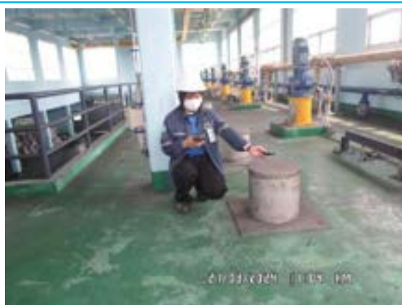
โรงจ่ายถ่านกัมมันต์ บ่อผสม No.1
