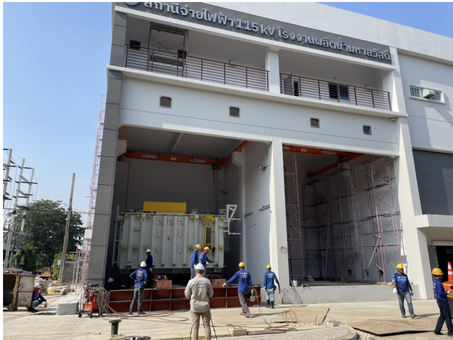
หม้อแปลงไฟฟ้ากำลัง (Power Transformer) ทั้ง 2 ชุด On-Site
