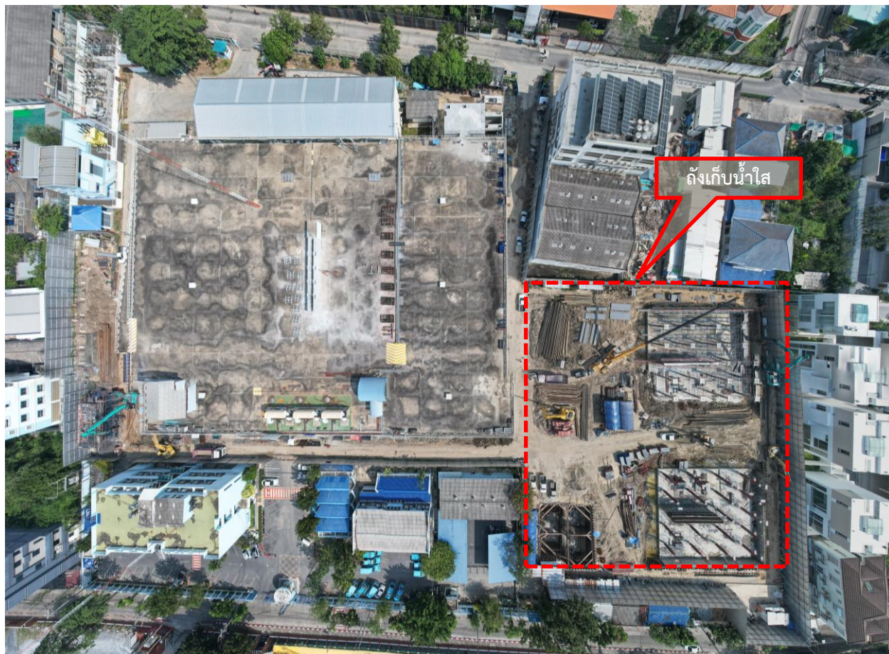
ภาพแสดงพื้นที่ก่อสร้างถังเก็บน้ำใต้อาคาร
