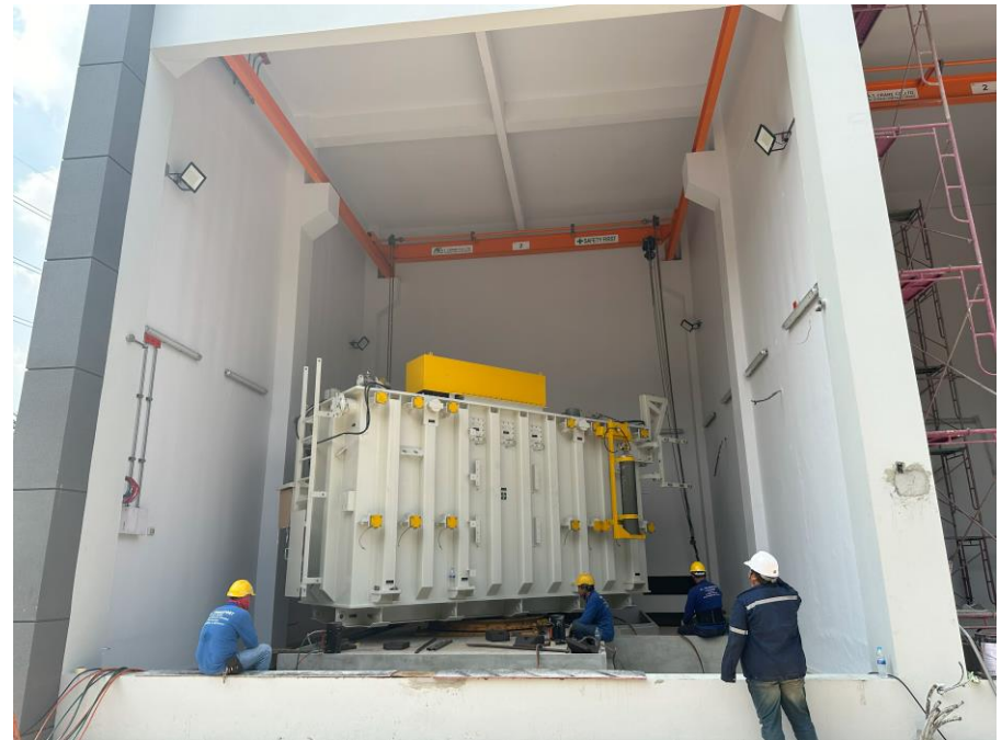
หม้อแปลงไฟฟ้ากำลัง (Power Transformer) ทั้ง 2 ชุด On-Site
