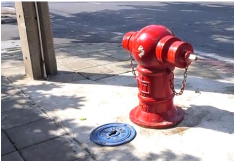
รูปแสดงประตุน้ำที่ใช้ในการเปิดปิดหัวดับเพลิง
