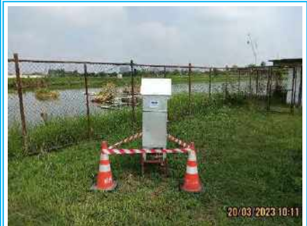
ถนนบริเวณกองควบคุมระบบกำจัดตะกอน จุดที่ 2 ถนนหมายเลข 6
