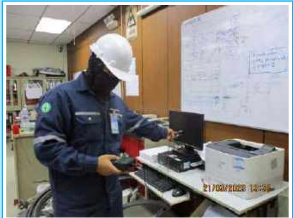
อาคารซ่อมบำรุงไฟฟ้า โต๊ะคอมพิวเตอร์ส่วนกลาง No.2
