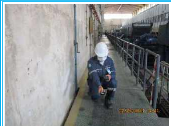
โรงสูบน้ำ 2 ทางเดินโรงสูบน้ำ 2
