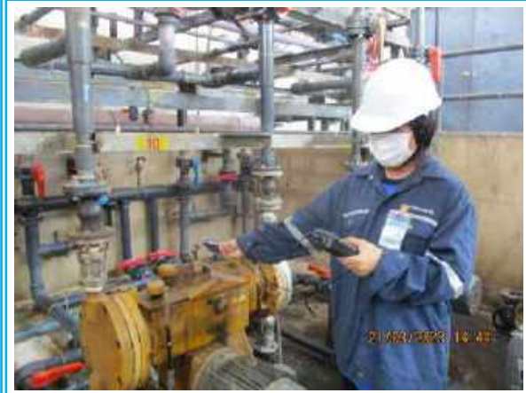
โรงจ่ายสารส้ม 2 บั้มจ่ายสารส้ม No.10
