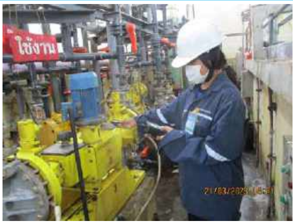
โรงจ่ายสารส้ม 1 บั้มจ่ายสารส้ม No.3
