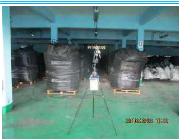
โรงจ่ายผงถ่านกัมมันต์
