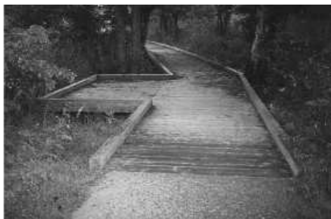
◀ ทางเดินยกระดับที่ใช้วัสดุไม้ และมีขอบทางกันรถเข็น คนพิการตกขอบสะพาน
