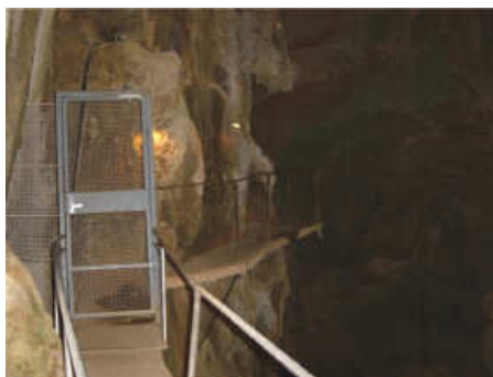
▼ เส้นทางผิวหน้าคอนกรีต
