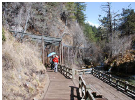
▲ สะพานทางเดินพื้นไม้ มีตะแกรงกันลื่นทับบนผิวหน้า มีชันชมทิวทัศน์ และการทำหลังคากันเศษไม้และหินหล่นใส่ อุทยานแห่งชาติจี่จ๋ายโกว ประเทศจีน
