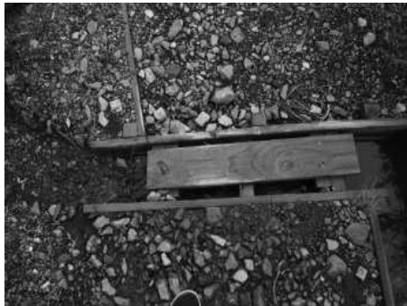
▲ ร่องระบายน้ำตัดผ่านผิวทาง และปิดด้วยแผ่นไม้ เพื่อสะดวกในการเดิน
