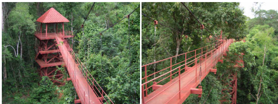
▲ เส้นทางศึกษาธรรมชาติเรือนยอดไม้ ที่สวนพฤกษศาสตร์ภาคใต้ (ทุ่งค่าย) จังหวัดตรัง สูง 3 ระดับ ระดับที่สูงที่สุดประมาณ 18 เมตร ยาว 178 เมตร ทำด้วยเหล็กและสลิง แต่ละช่วงยาว 30 เมตร ไม่มีป้ายสื่อความหมาย
