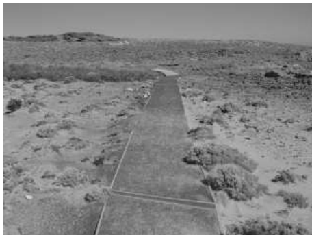
▲ ทางระบายน้ำตัดผ่านผิวทาง
