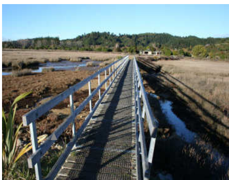
▲ สะพานทางเดินแบบไม้ที่มีตะแกรงลวดปูด้านบน กันลื่น อุทยานแห่งชาติ Abel Tasman ประเทศนิวซีแลนด์
