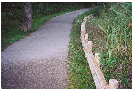
▲ ผิวหน้าเส้นทางที่เป็นแอสฟัลต์และมีราวกันตกขอบทาง
