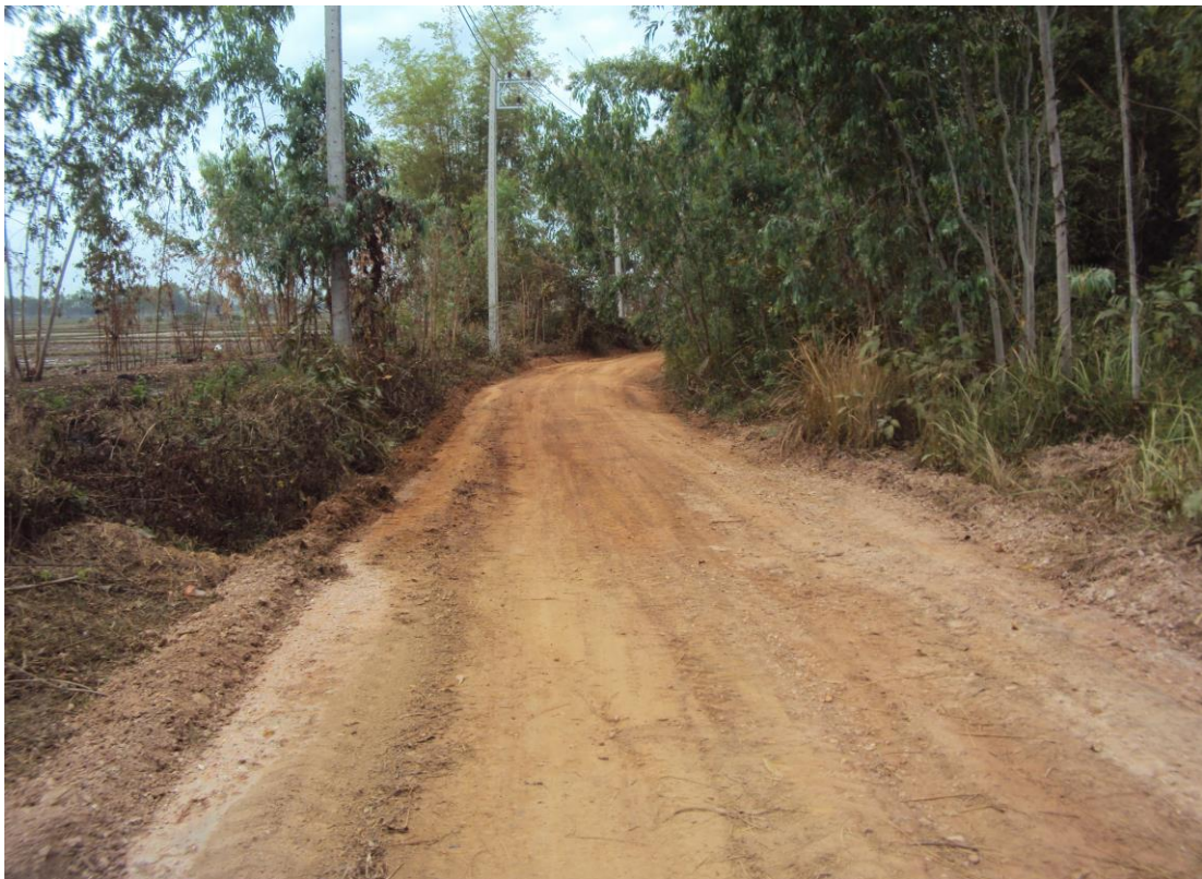
โครงการก่อสร้างถนนลูกรัง ในเขตพื้นที่ตำบลสีกาย
