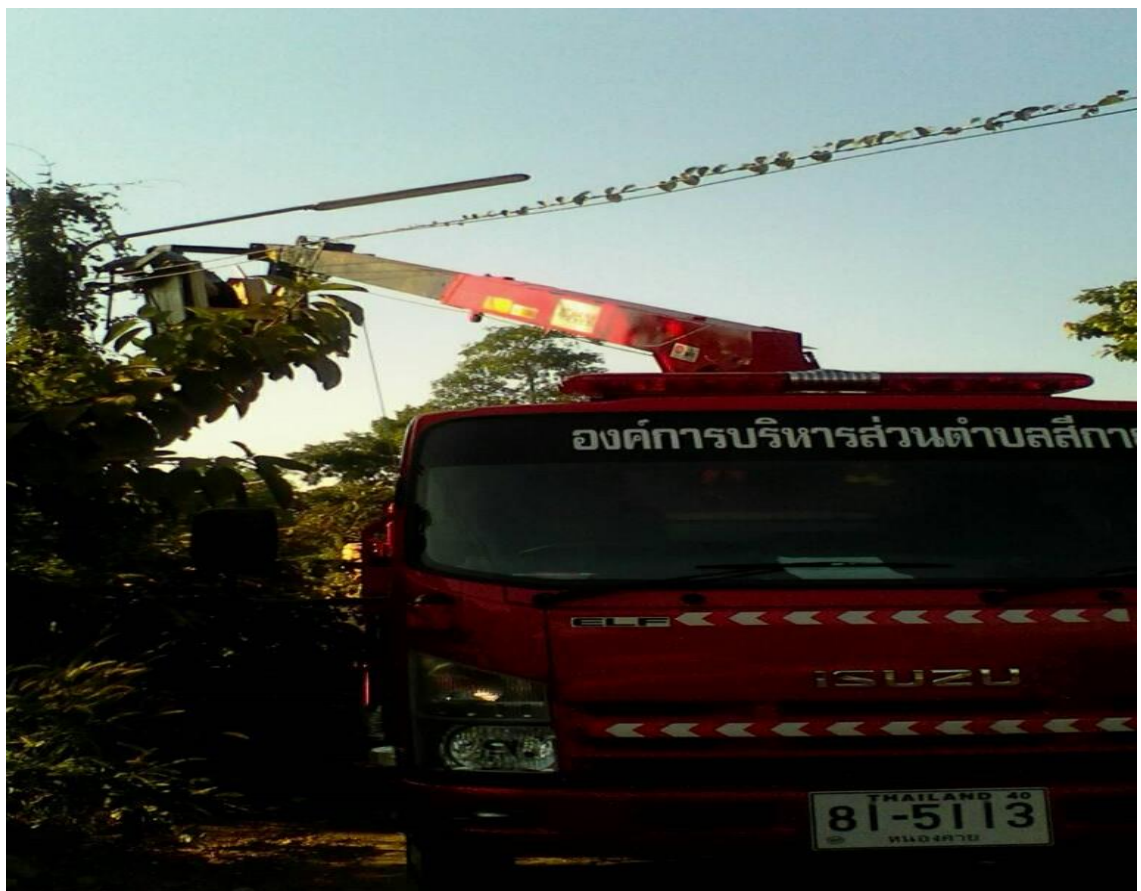
ซ่อมไฟฟ้าส่องสว่างในเขตพื้นที่ตำบลสีกาย
