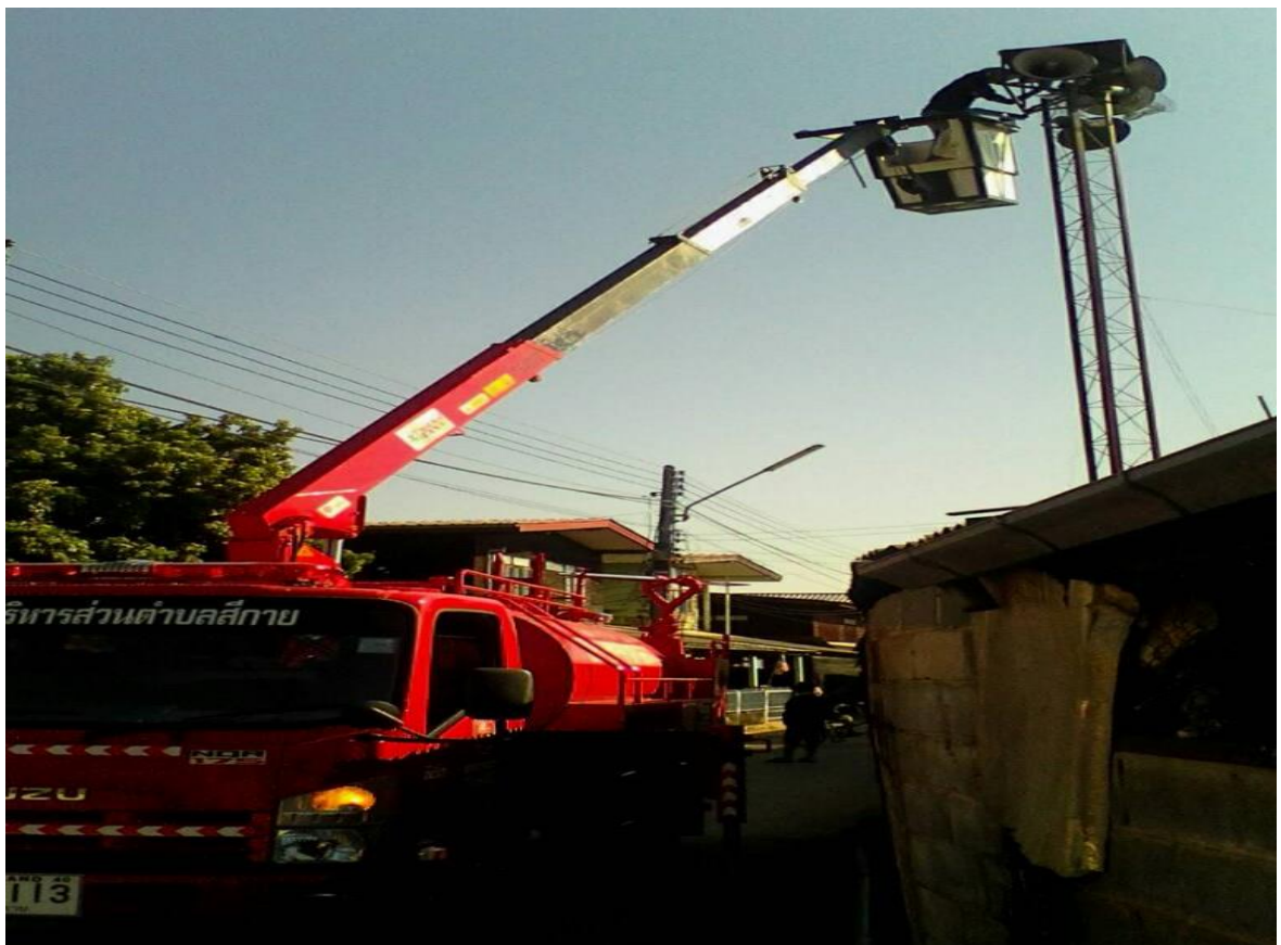
ซ่อมแซมหอกระจายข่าวในพื้นที่ตำบลสีกาย
