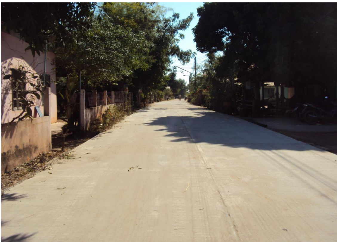
โครงการปรับปรุงผิวถนนคอนกรีตเสริมเหล็กภายในหมู่ที่ ๔ บ้านบง
