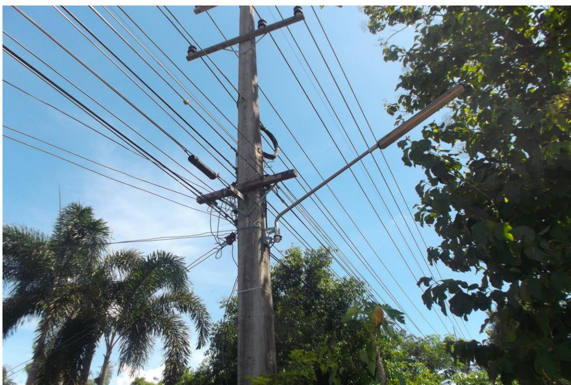
ซ่อมไฟฟ้าส่องสว่างในเขตพื้นที่ตำบลสีกาย
