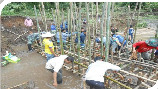
งานสร้างฝายชะลอน้ำ งานส่วนป่าบ้านงา
