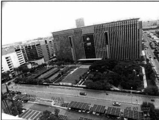
สภาพผิวจราจรทางเข้า-ออกอาคาร (ถนนป๊อปปูล่า)
