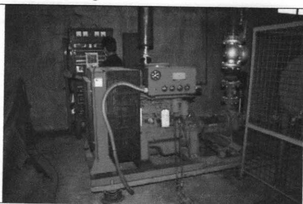
ปั้มน้ำดับเพลิง
