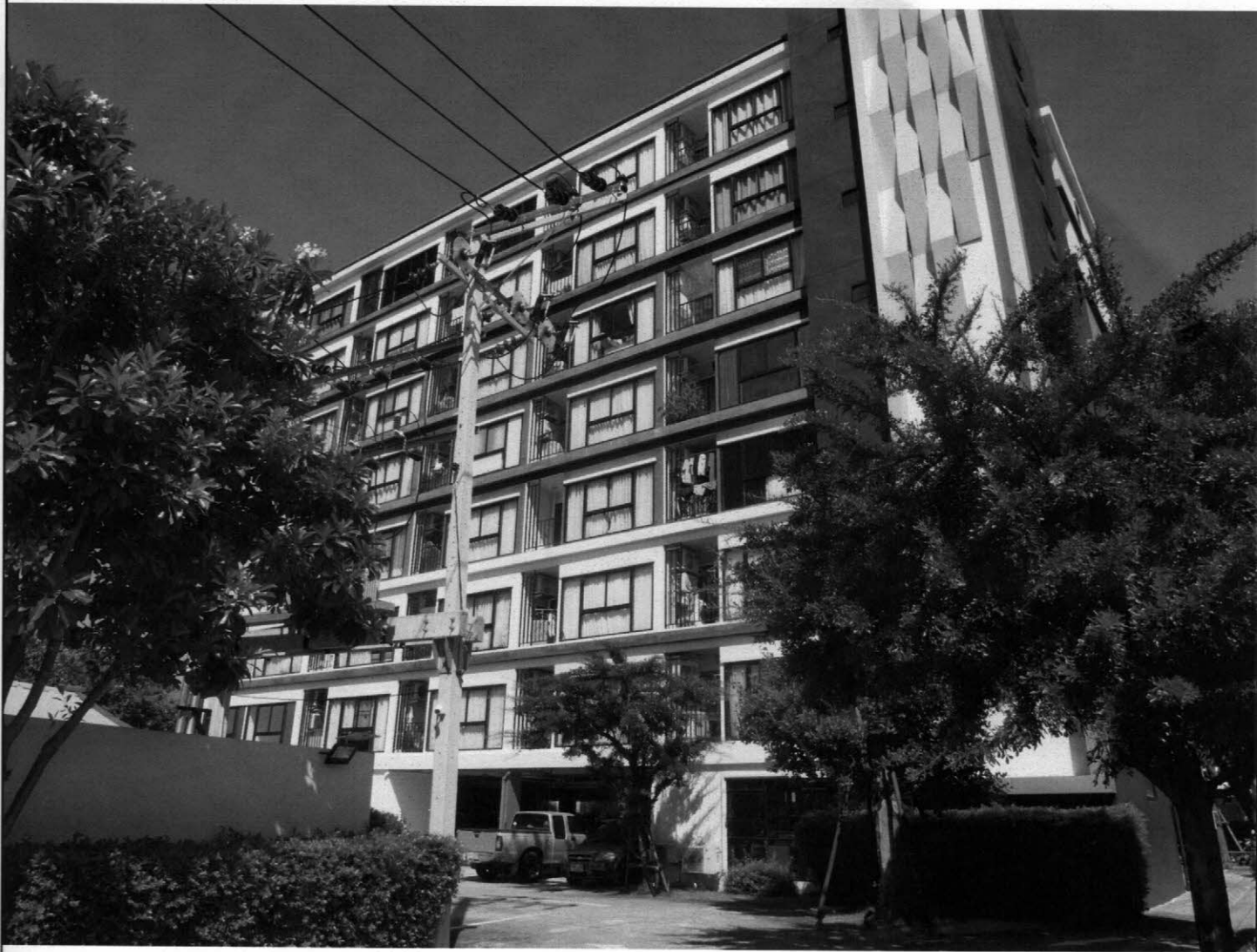
รูปภาพอาคาร เพลิน เพลิน คอนโดมิเนียม แจ้งวัฒนะ-ปากเกร็ด ตรวจสอบอาคาร เดือน พฤศจิกายน 2566
