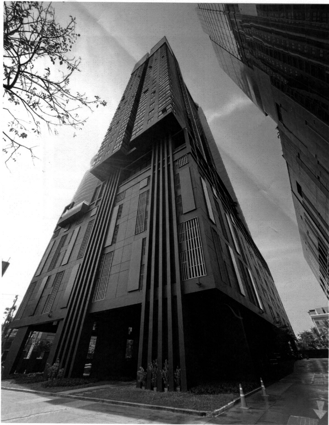
รูปภาพอาคาร เอสโพร คอนโดมิเนียม ตรวจสอบอาคาร เดือน พฤษภาคม 2566
