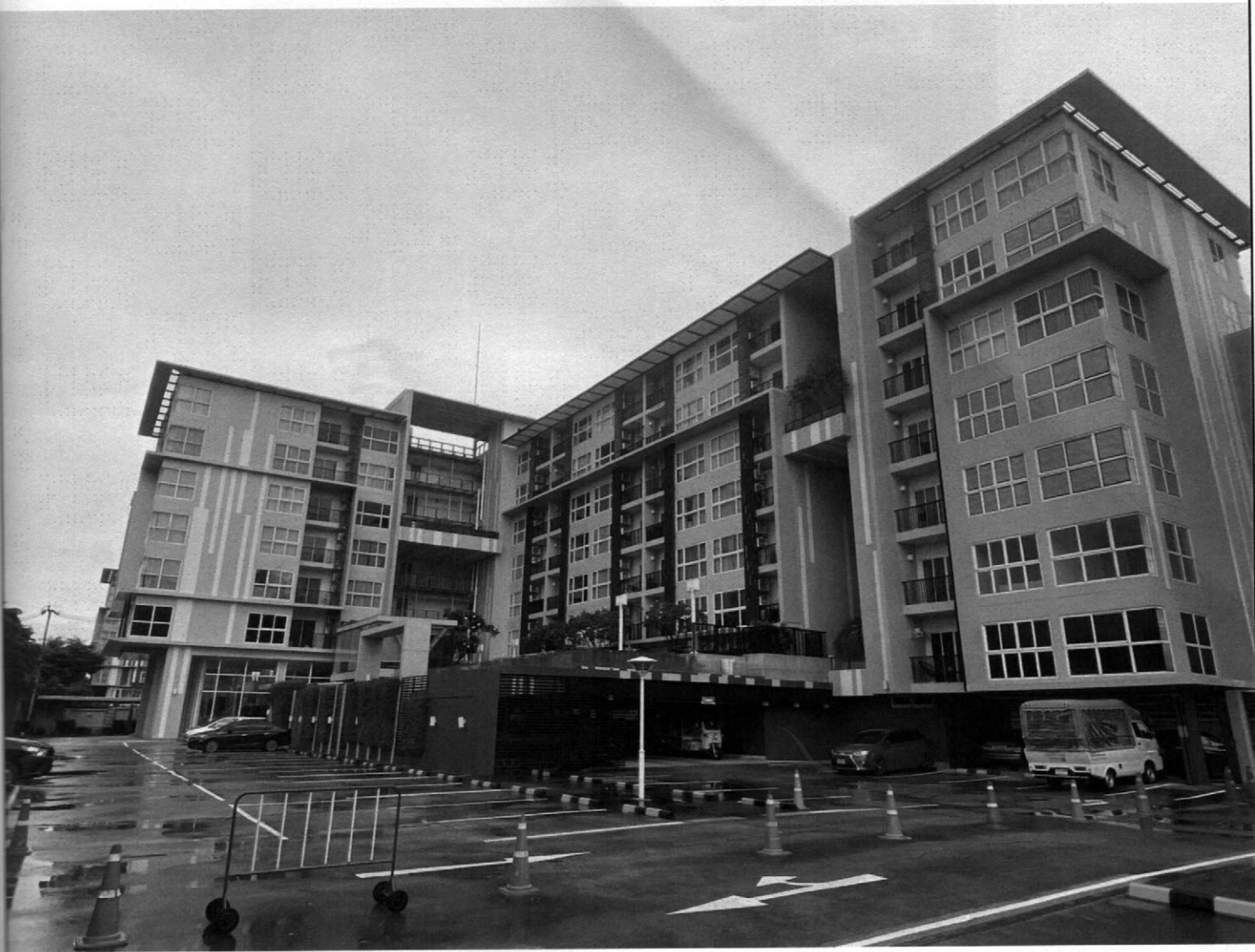
รูปภาพอาคาร ดับเบิลเลค คอนโดมิเนียม เฟส 2 (อาคาร 2) ตรวจสอบอาคาร เดือน ตุลาคม 2566
