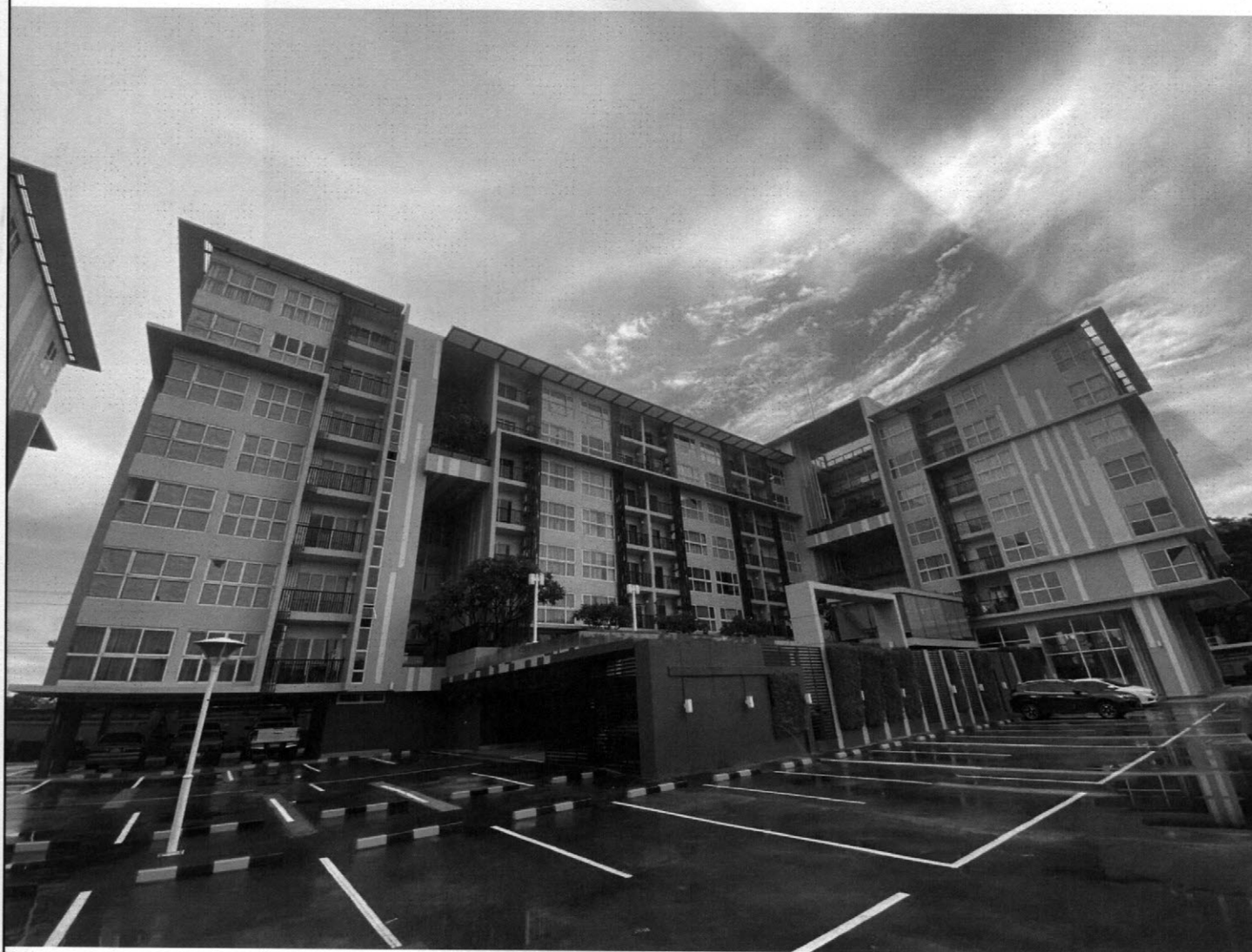
รูปภาพอาคาร ดับเบิลเลค คอนโดมิเนียม เฟส 2 (อาคาร 3) ตรวจสอบอาคาร เดือน ตุลาคม 2566
